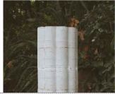
02 Fuente exterior de hormigón insitu
