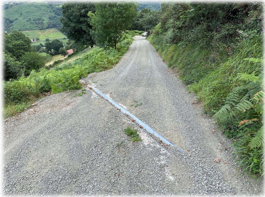
Fotografía 10 – Vista general del camio a acondicionar, con bionda a recolocar
