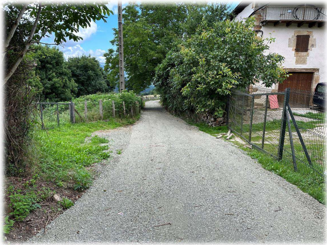
Fotografía 1 – Vista general del camio a acondicionar
