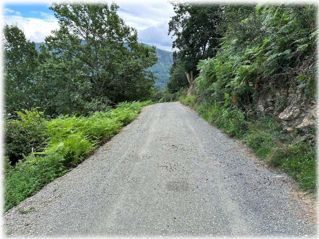
Fotografía 9 – Vista general del camio a acondicionar
