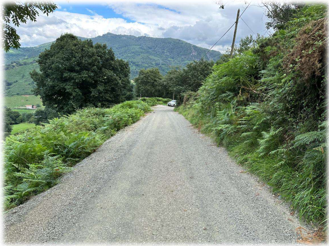
Fotografía 11 – Vista general del camio a acondicionar
