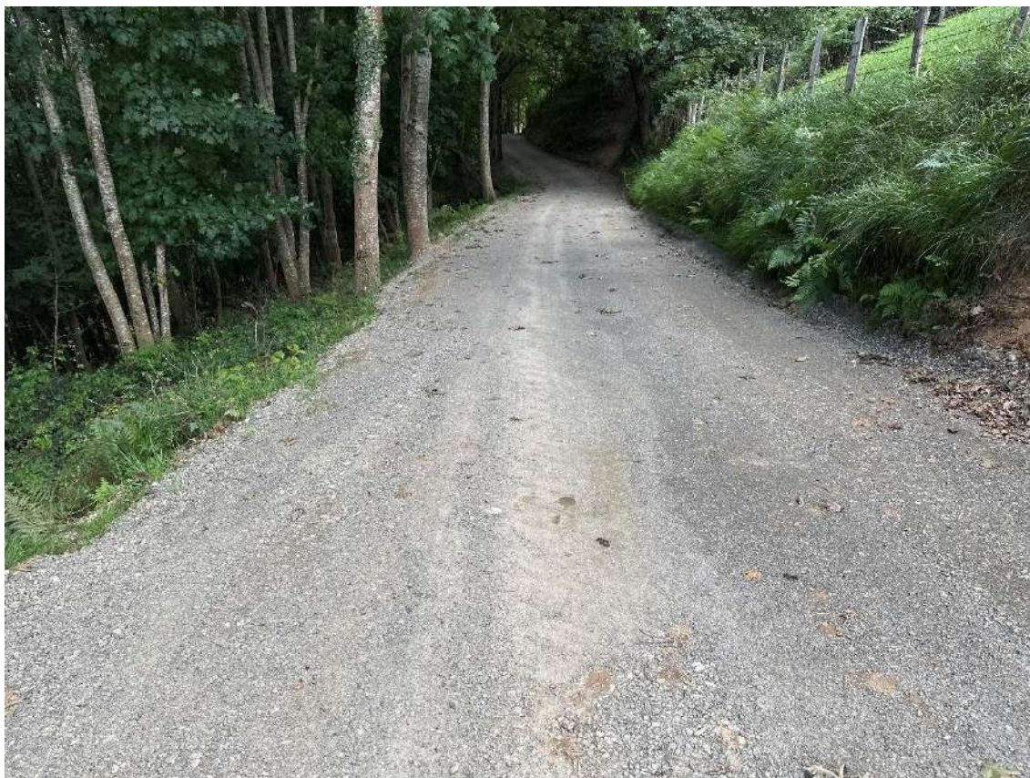
Fotografía 7 – Vista general del camio a acondicionar
