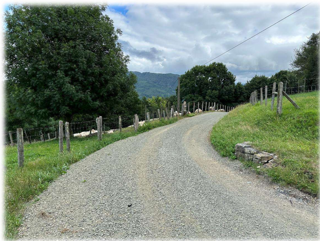
Fotografía 4 – Vista general del camio a acondicionar
