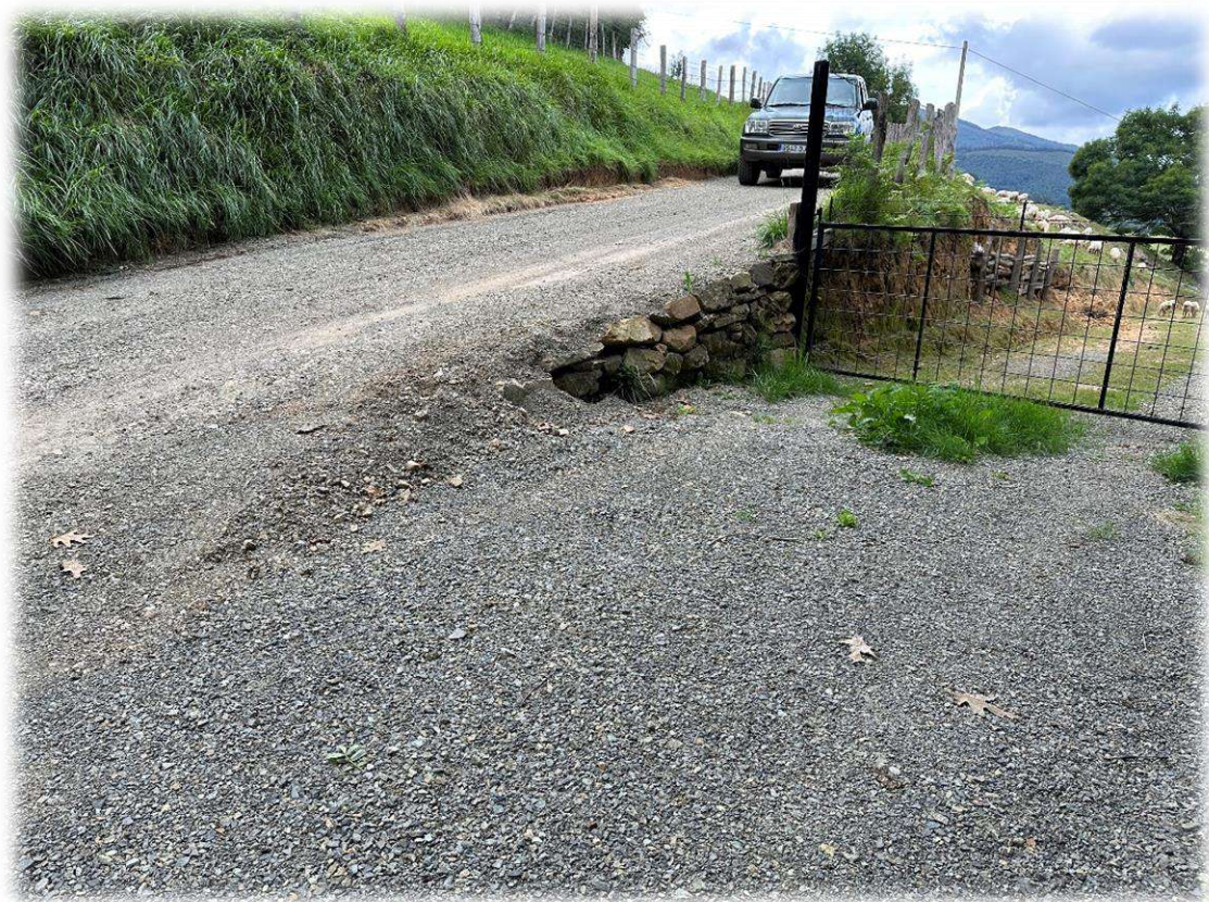
Fotografía 6 – Vista general del camio a acondicionar
