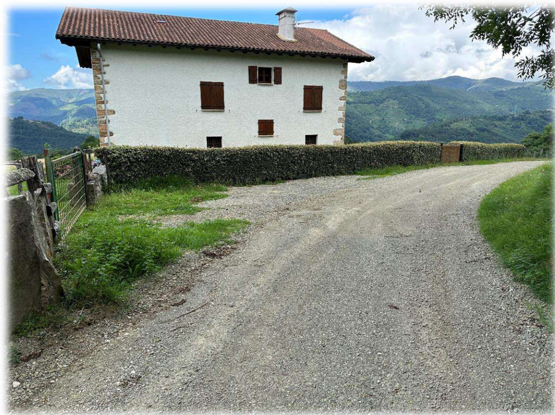
Fotografía 3 – Vista general del camio a acondicionar
