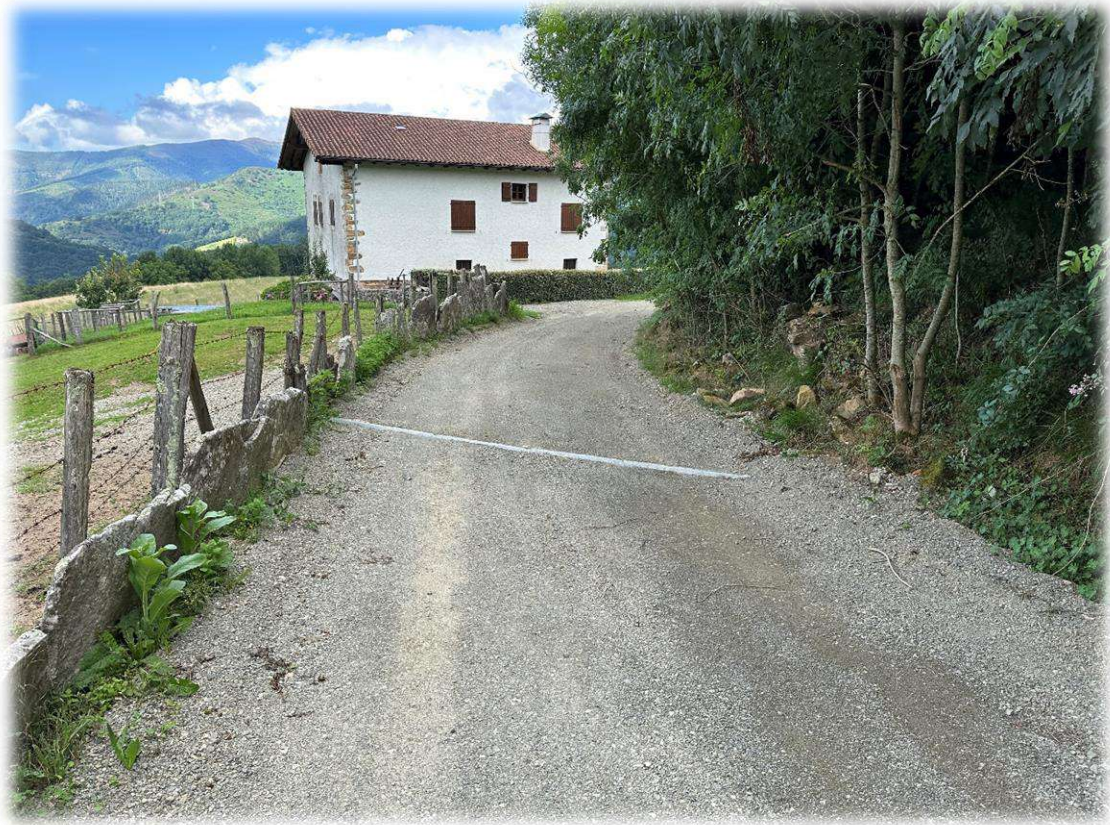
Fotografía 2 – Vista general del camio a acondicionar, con bionda a recolocar
