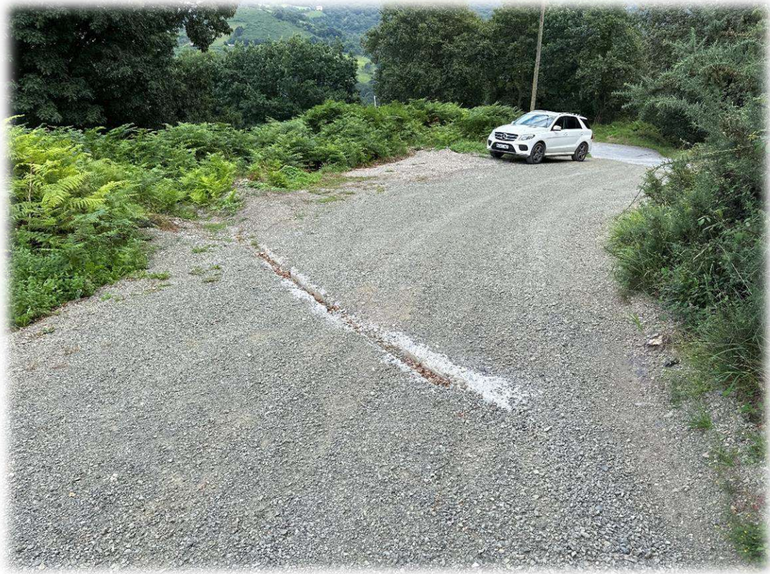
Fotografía 12 – Vista general del camio a acondicionar, con bionda a recolocar
