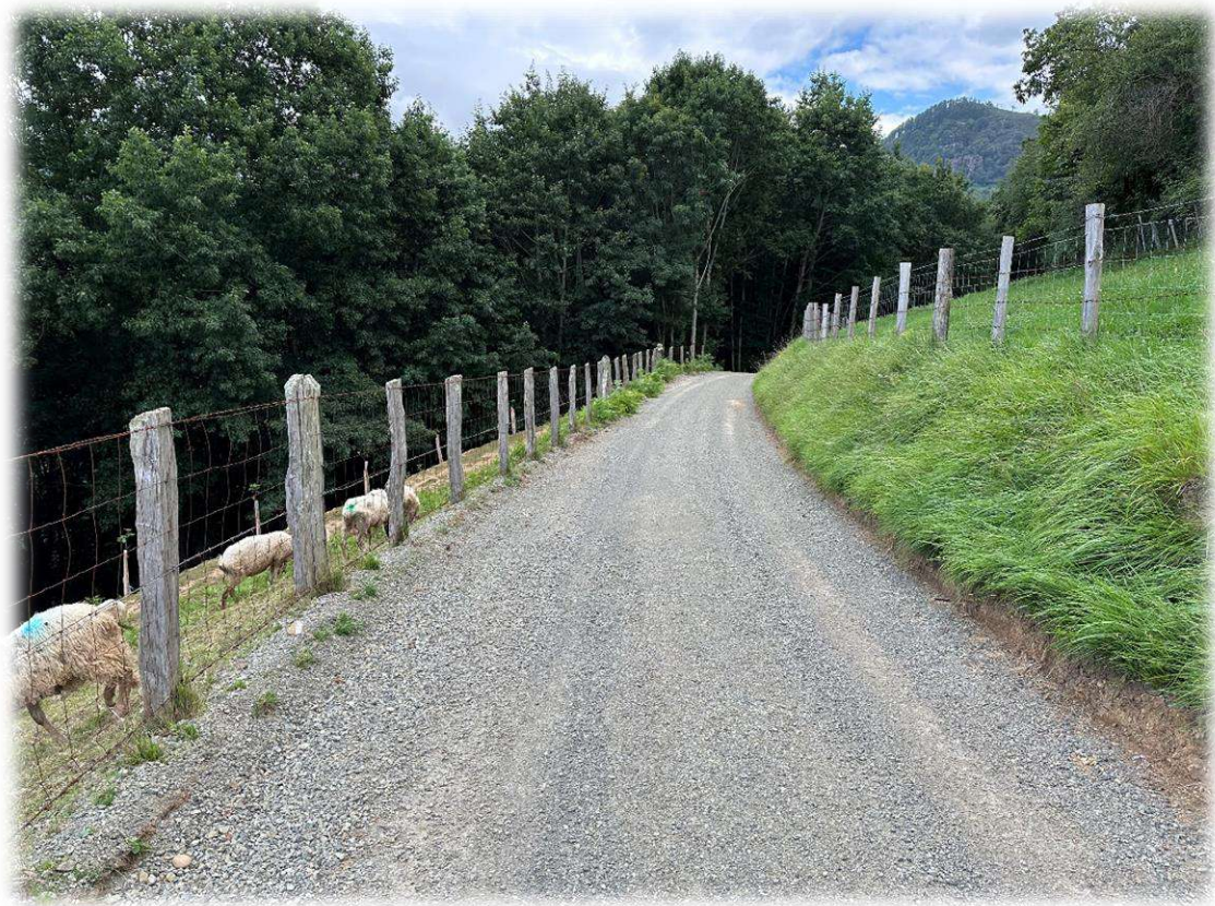
Fotografía 5 – Vista general del camio a acondicionar
