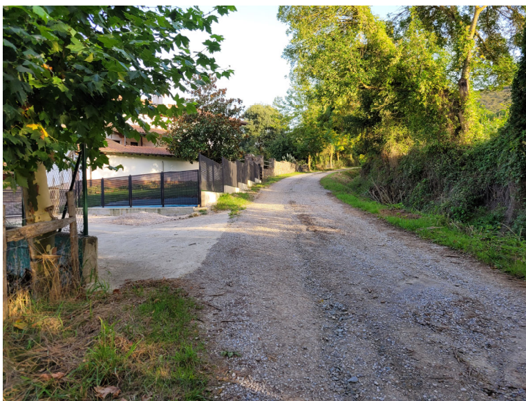
Imagen 07. Entronque con acceso a vivienda.
