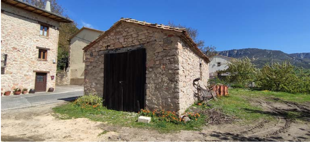
Foto 1: Edificio La Fragua.
