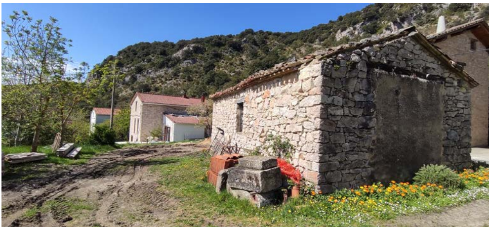
Foto 2: Edificio La Fragua.
