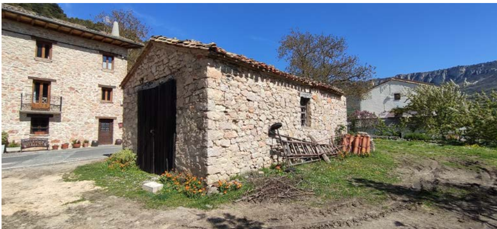
Foto 3: Edificio La Fragua.
