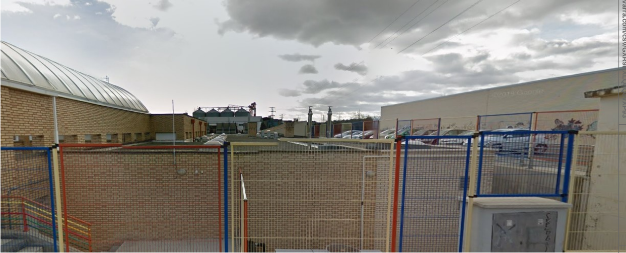
Edificios con cubierta plana
