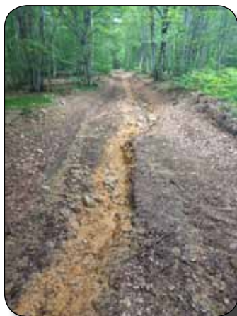
Rampa de fuerte pendiente
