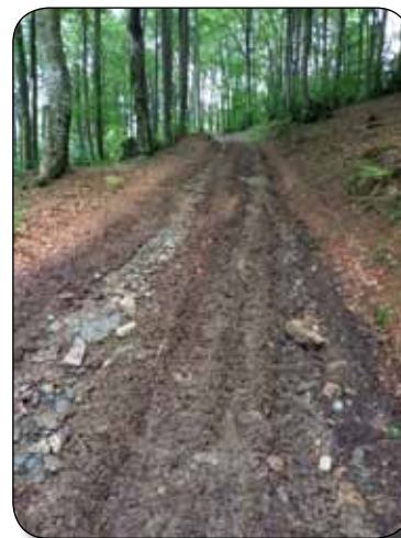
Continuación de la rampa con materiales mixtos
