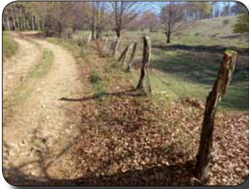
Tres imágenes del estado de conservación de este cerramiento
