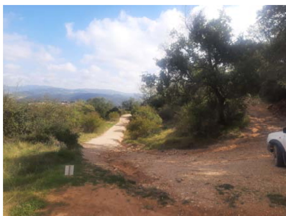
Vista del Camino del Monte en su pk0,32
