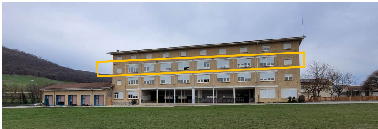
Fotografía 01. Vista general del edificio. Zona de actuación.
