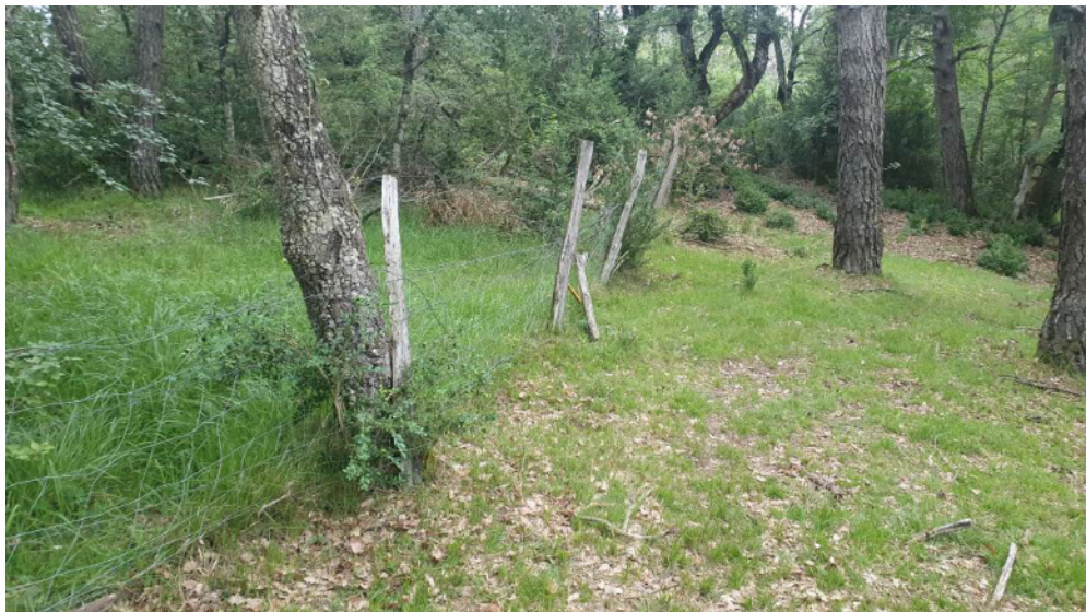
Fotografía del estado actual del cierre.
