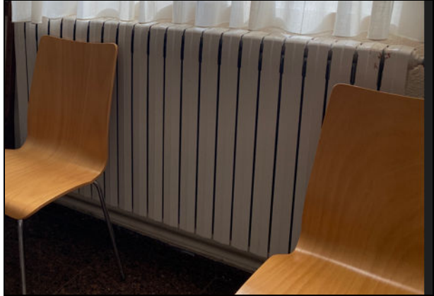
Imagen. Hierro fundido 800x102, 22 módulos
