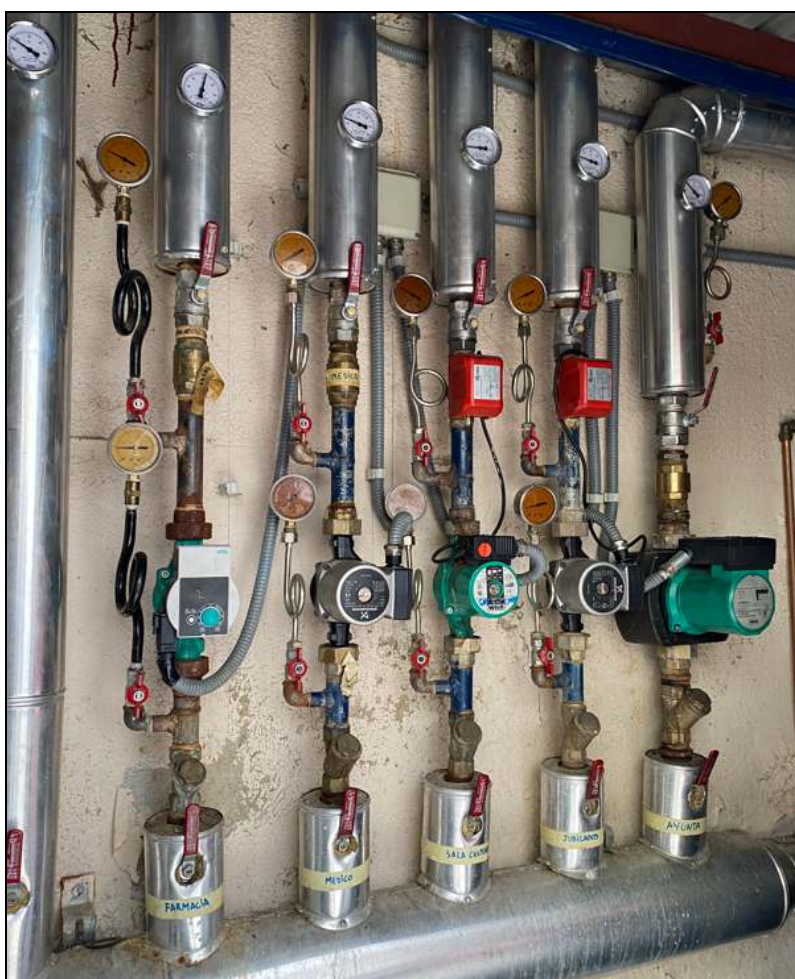
Detalle colector impulsión.
