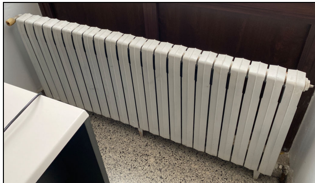
Imagen. Radiador hierro fundido 500x102 de 22 módulos
