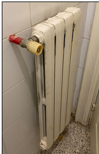
Imagen. Radiador: hierro fundido 650x63, 4 módulos
