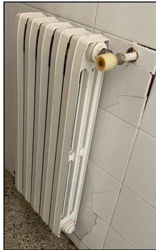
Imagen. Radiador: hierro fundido 650x102, 5 módulos
