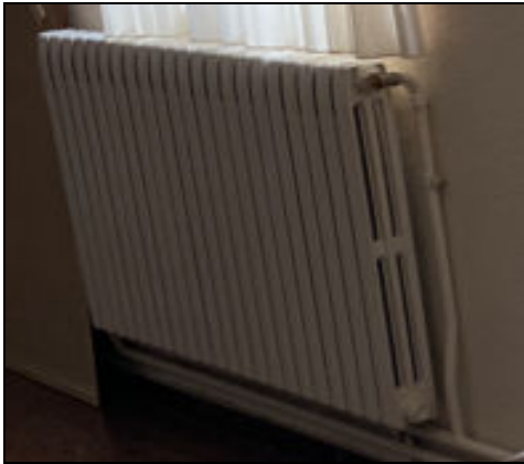
Imagen. Hierro fundido 800x102, 22 módulos
