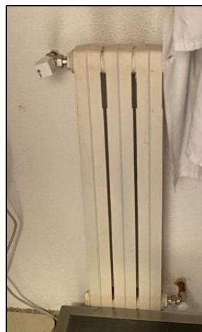
Imagen. Radiador hierro fundido 650x63 de 3 módulos
