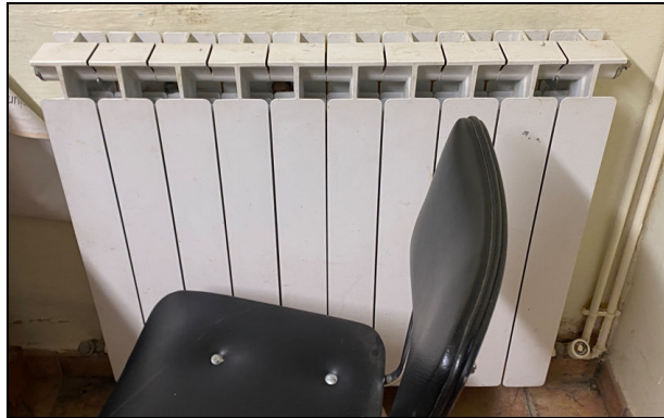
Imagen. Radiador Dubal alum. 60, 10 módulos
