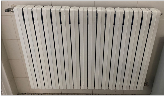
Imagen. Radiador: hierro fundido 650x102 17 módulos y 16 módulos (respectivamente)
