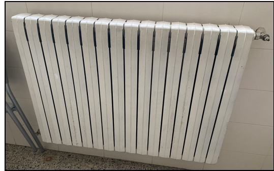
Imagen. Radiador: hierro fundido 650x102 17 módulos y 16 módulos (respectivamente)
