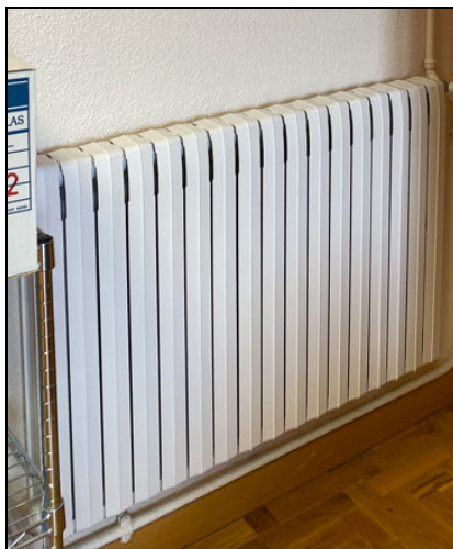
Imagen. Hierro fundido 650x102, 17 módulos
