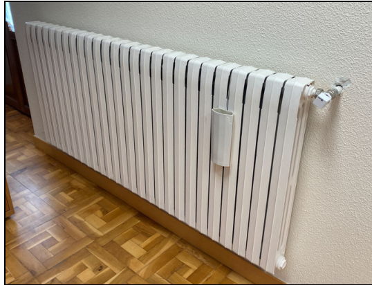
Imagen. Hierro fundido 650x102, 26 módulos
