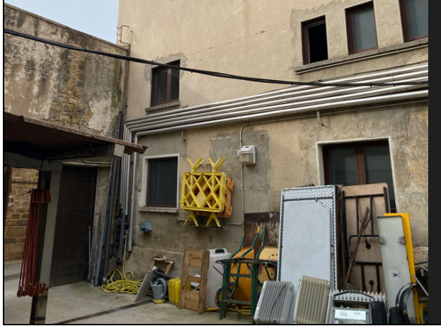
Imagen. Acceso al patio
