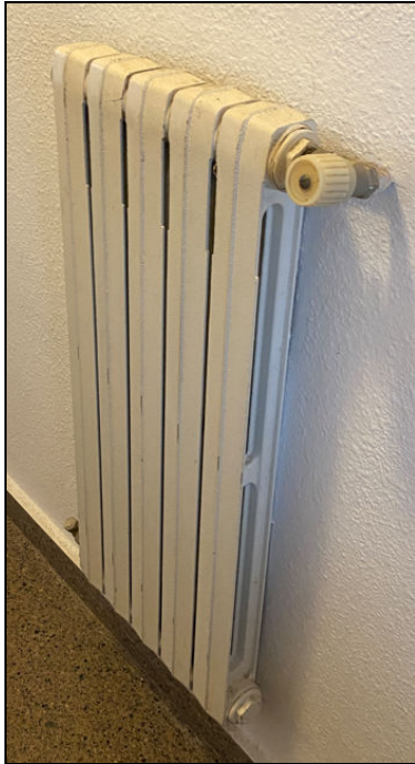
Imagen. Radiador hierro fundido 800x102 - 5 módulos
