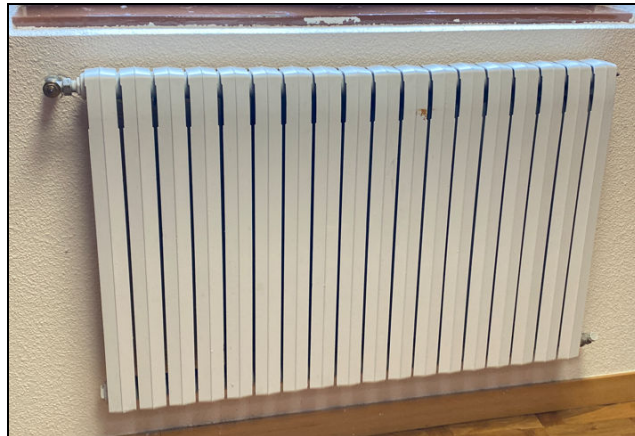
Hierro fundido 650x102, 18 módulos
