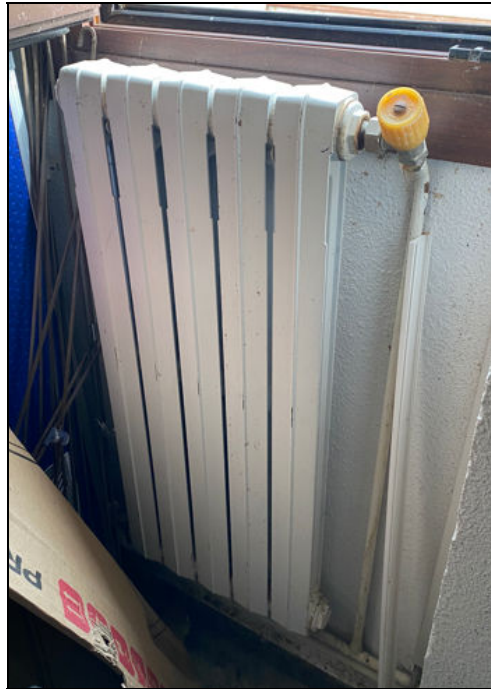
Imagen. Radiador hierro fundido 800x102 - 5 módulos
