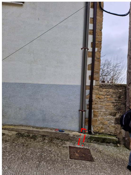
Ilustración 3: Tramo FV 3. Zanja por realizar
