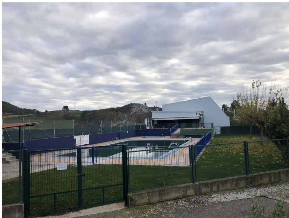
Fotografía 04. Zona ajardinada actual al mismo nivel que las piscinas
