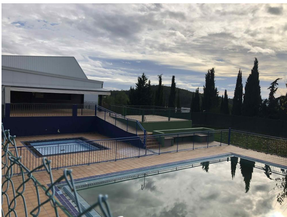
Fotografía 06. Comunicación existente entre niveles
