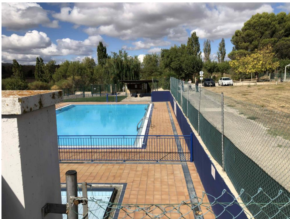
Fotografía 05. Desnivel entre piscina y campo de fútbol
