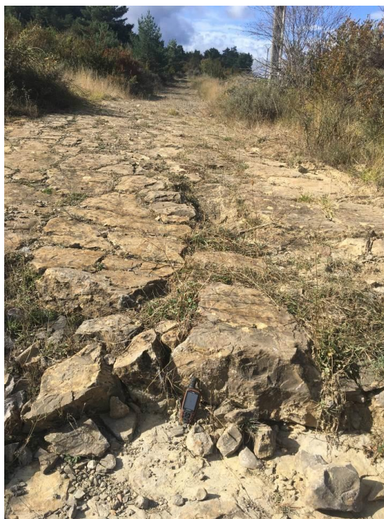
Imagen 8. Tramo inicial con base formada por losa de piedra que forma desniveles al fragmentarse que es necesario disgregar.
