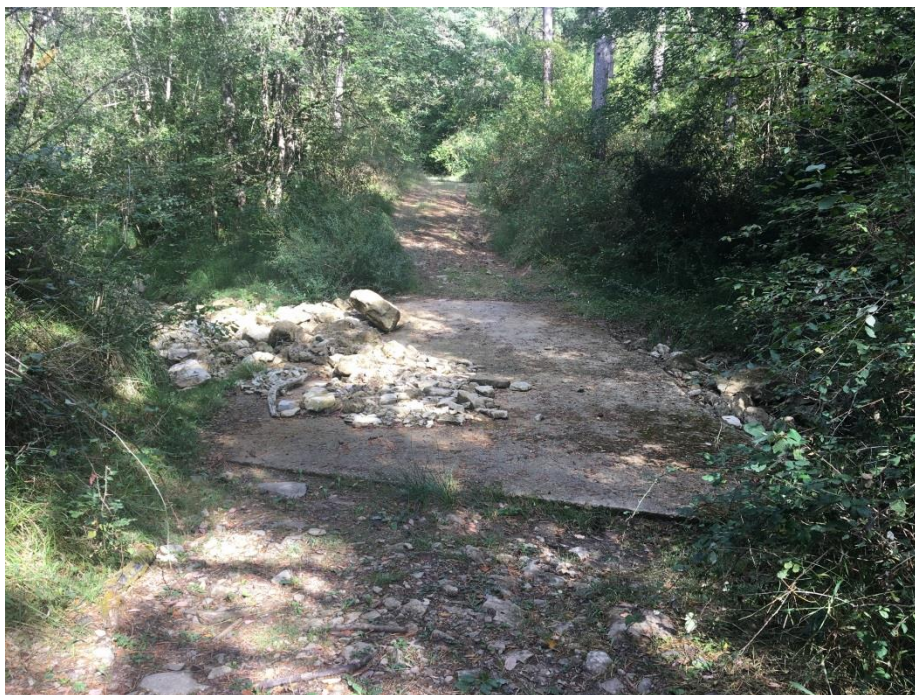
Imagen 10. Punto donde se prevé la colocación de un caño soterrado.
