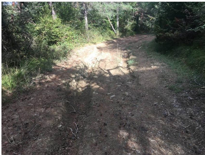
Imagen 4. Tramo con blandones en el que son evidentes las rodadas.
