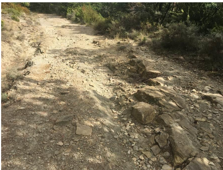
Imagen 3. Tramo en el que se han lavado elementos finos dejando roca en superficie.
