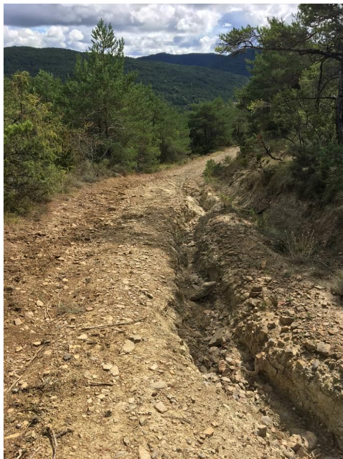
Imagen 1. Tramo en el que se han formado surcos de gran profundidad.
