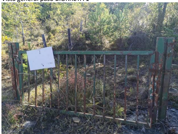
Reparo de tierras en el entorno del portillo
