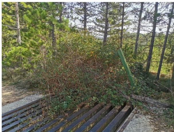
Detalle paso IZANOZ 1 vegetación a eliminar y poste a enderezar.
