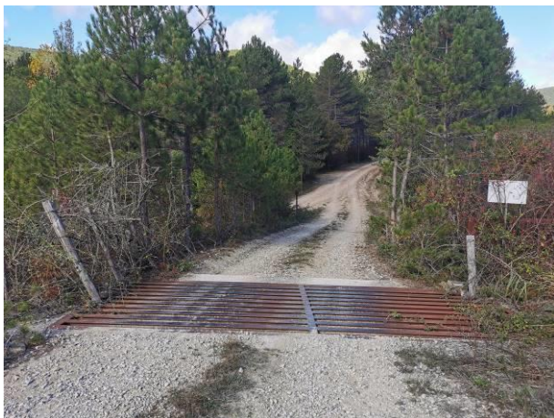
Vista general paso OLABERRI 3
