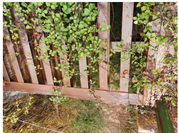
Detalle vegetación saliendo del paso en su lado derecho.
