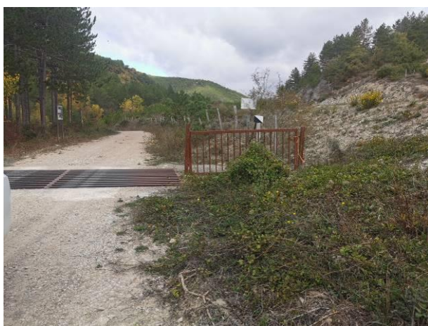
Vista general paso OLABERRI 1
