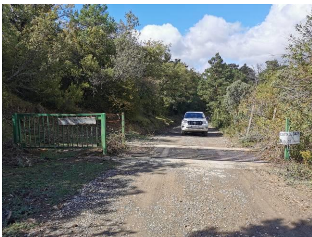
Vista zona portillo a reperfilar
