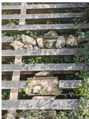
IPN de 180 cortadas para liberar animal soldar y reforzar.
