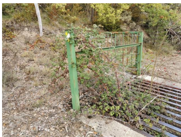
Detalle vegetación saliendo del paso en su lado derecho.
