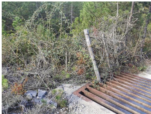
Salida al paso en el que se debe dotar de pendiente y liberar de vegetación.
