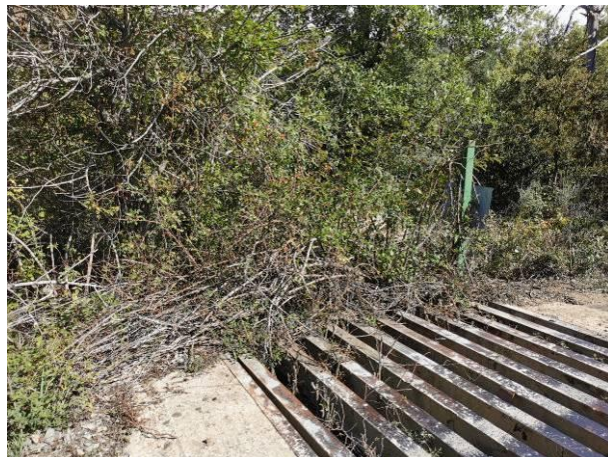
Vista salida del paso con vegetación a extraer poste a enderezar y a colocar nuevo.
