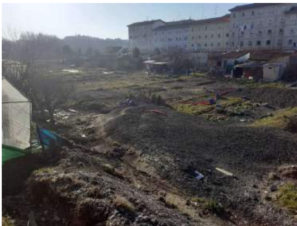
Foto 19: Montones de asfalto acumulados al final del aparcamiento sobre el terreno de las huertas colindantes.
