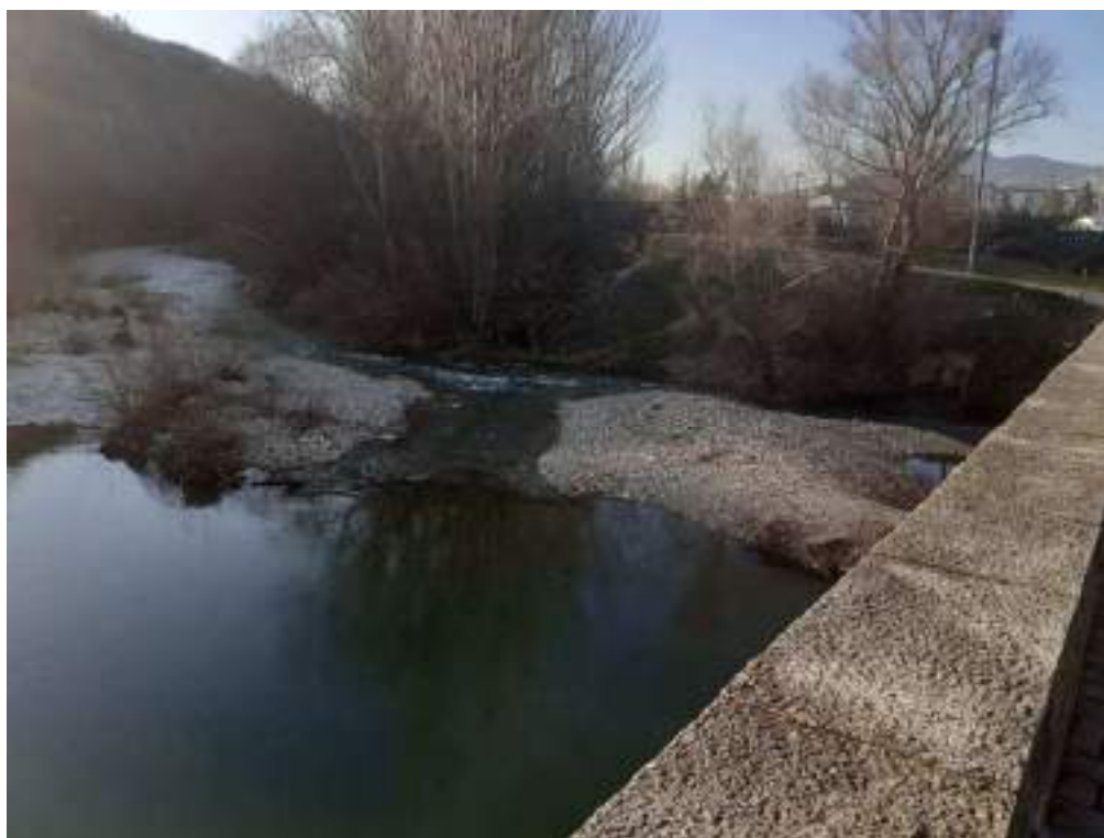
Foto 15: Acarreos aguas abajo puente Viejo de Burlada.
