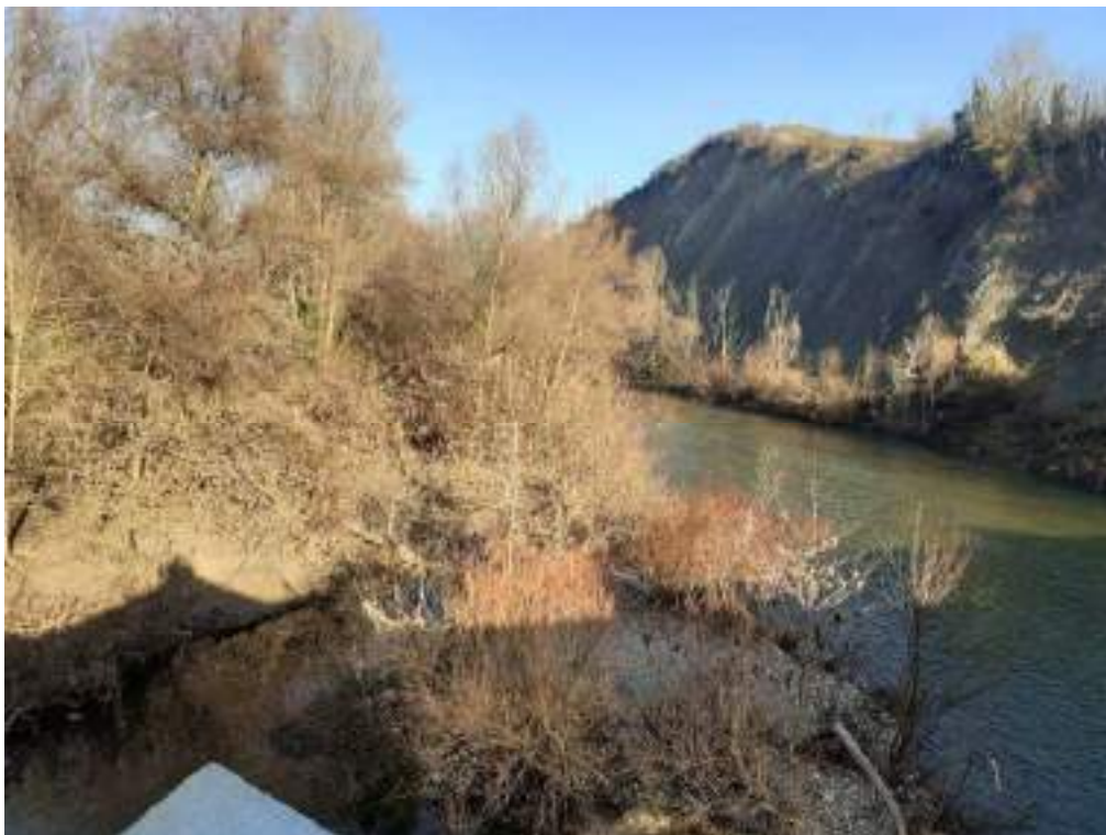
Foto 14: Islas de depósitos aguas arriba del puente viejo de Burlada, taponando los dos vanos derechos.
