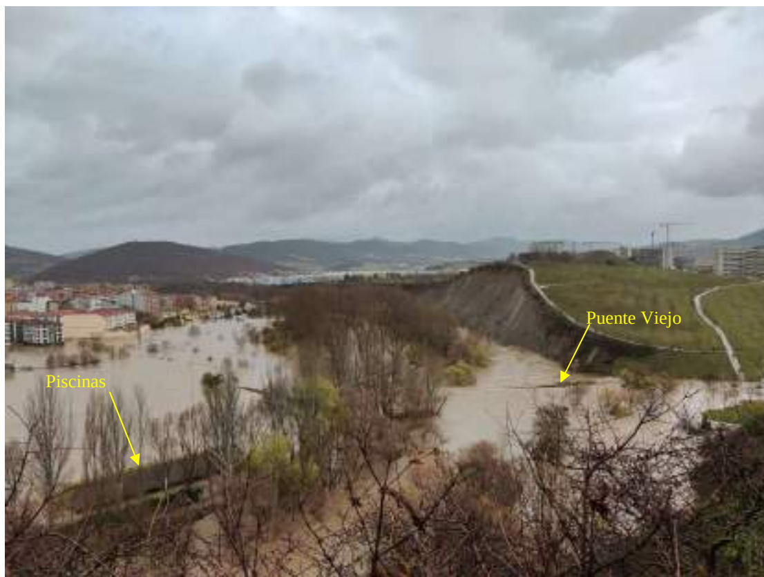
Foto 1: Vista general de la inundación del día 10-12-2021. En la parte izquierda de la fotografía puede verse la altura alcanzada por el agua junto a las piscinas cubiertas (3,20 m de calado). El pretil del puente Viejo de Burlada se vio sobrepasado por las aguas. Toda la plataforma aluvial de Burlada acabó inundada.
