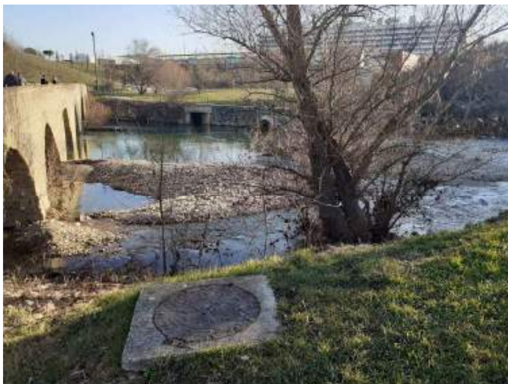
Foto 5: Depósitos de acarreo dejados por las avenidas aguas abajo del puente Viejo de Burlada.
