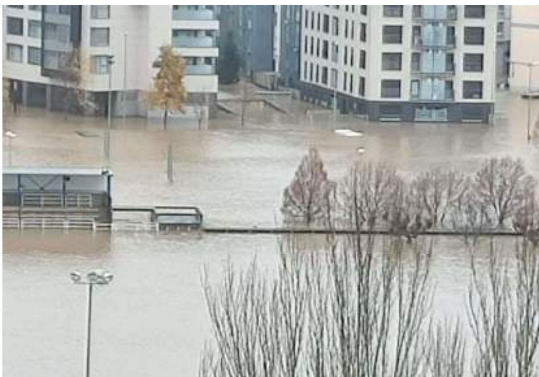
Foto 2: Vista de la inundación. Al fondo de la fotografía puede verse la plaza río Arga anegada por las aguas. En primer plano las pistas de atletismo de Burlada.
