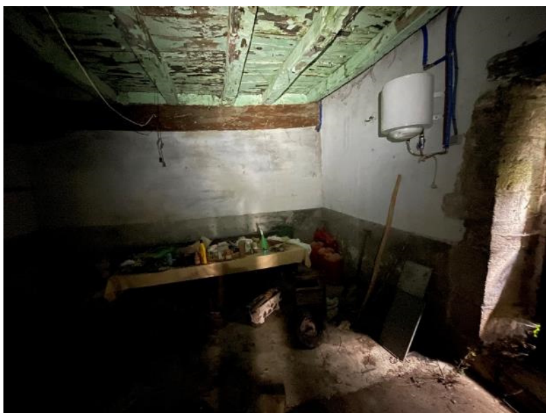
Zona comedor y pasillo acceso
