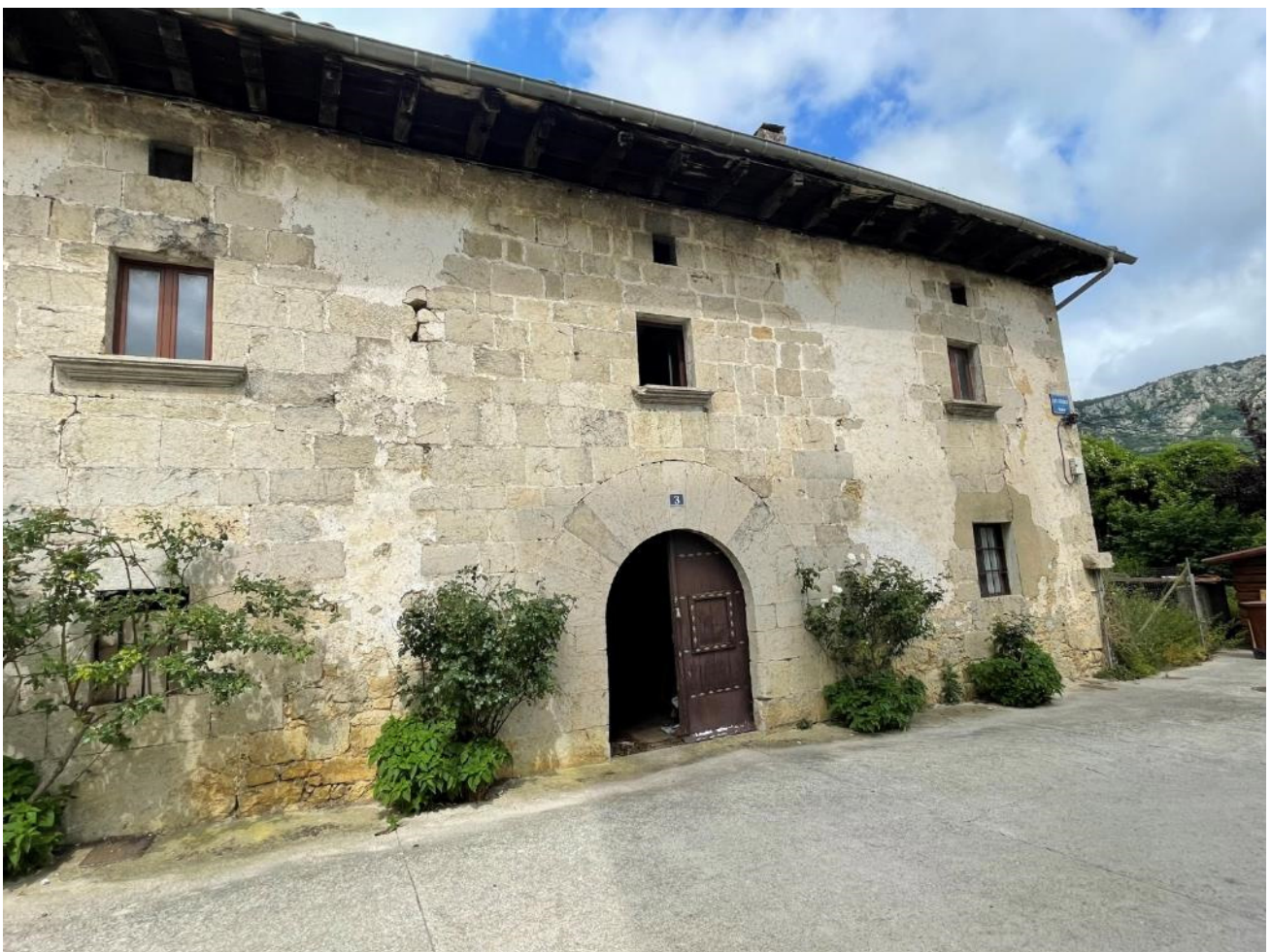
fachada principal ( este)
