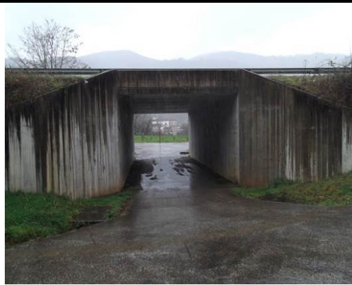
15. Paso subterráneo de la N-121-A
