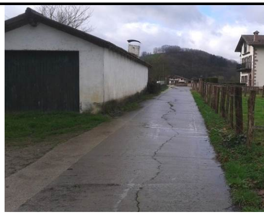
77. Camino antigua vía, hormigonado.
