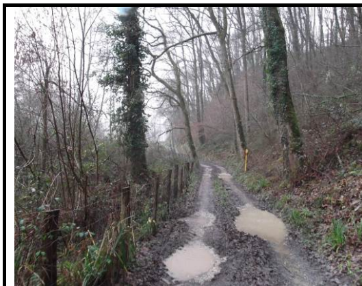
72. Camino antigua vía. Problemas encharcamientos.
