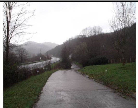
14. Camino hormigonado a Narbarte
