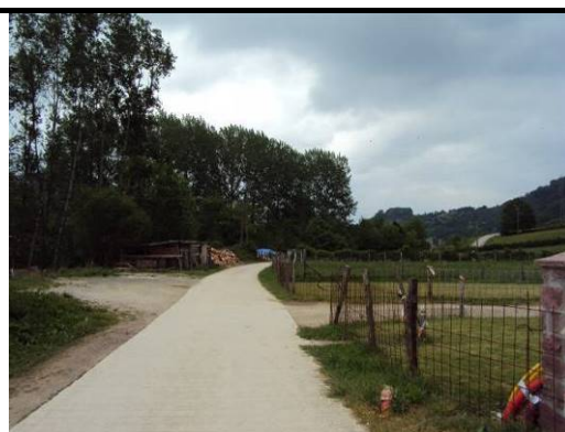
10. Salida de Legasa hormigonada
