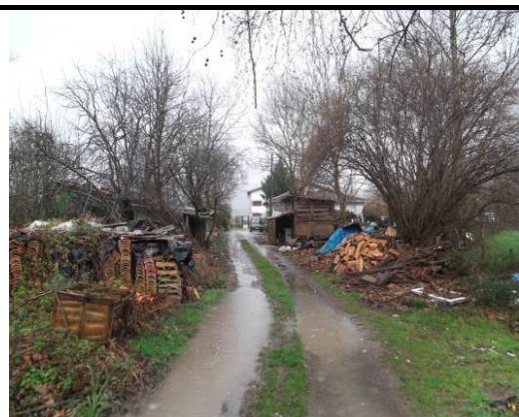
73. Camino antigua vía. Problemas encharcamientos.
