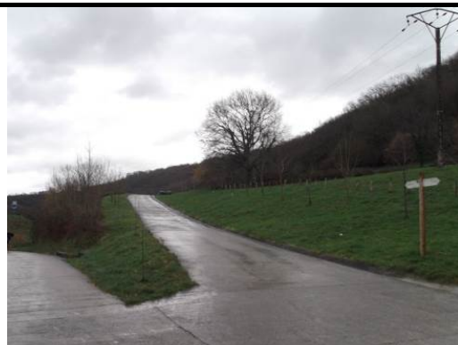
12. Camino hormigonado a Narbarte
