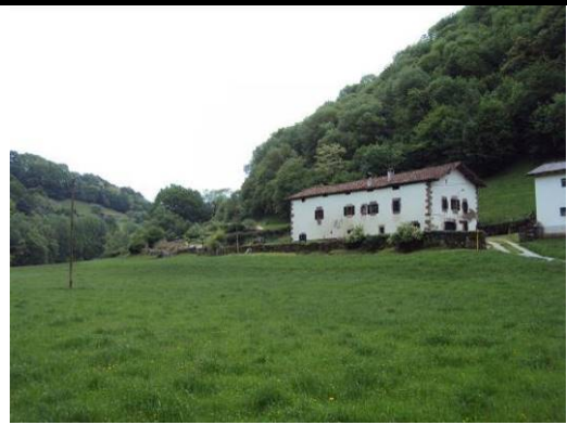
49. Vista general caserío Ugaldea
