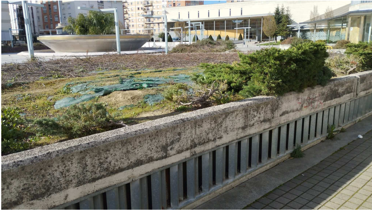
Fig. 3. Vista muro jardinera y fuente ornamental
