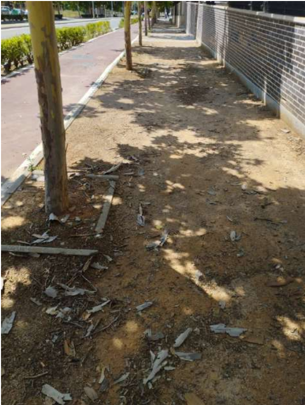
Tramo de acera a intervenir.
