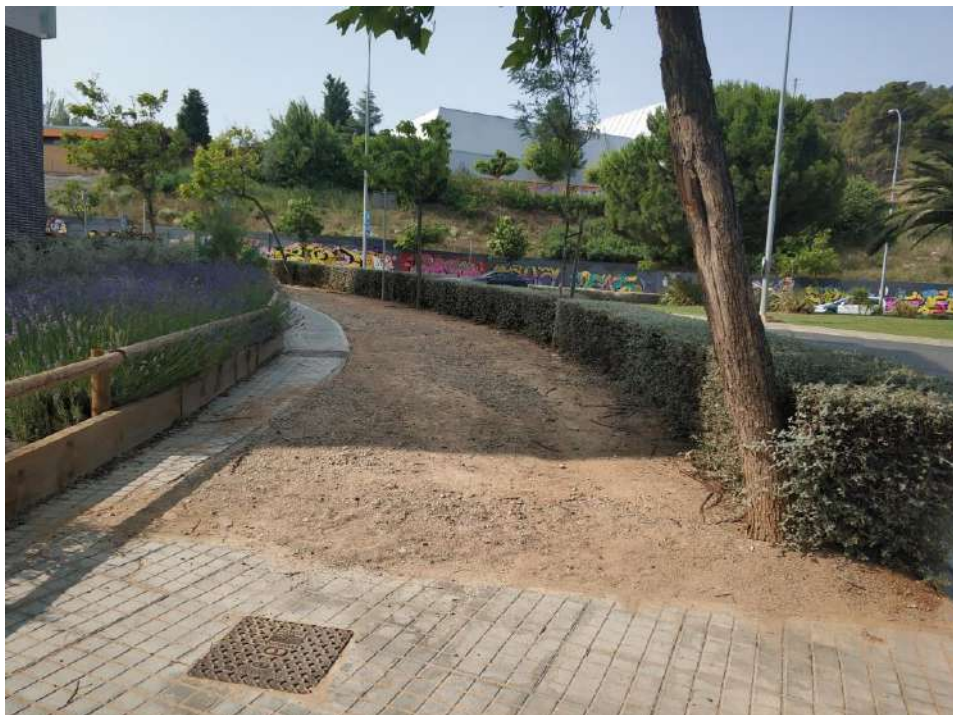
Tramo de acera a intervenir.
