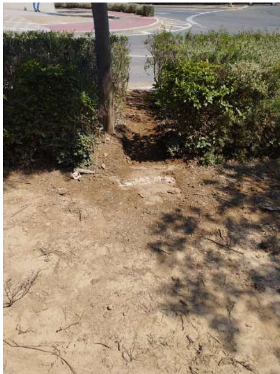
Zonas de paso entre setos para hacer caz de hormigón para evacuación de agua.
