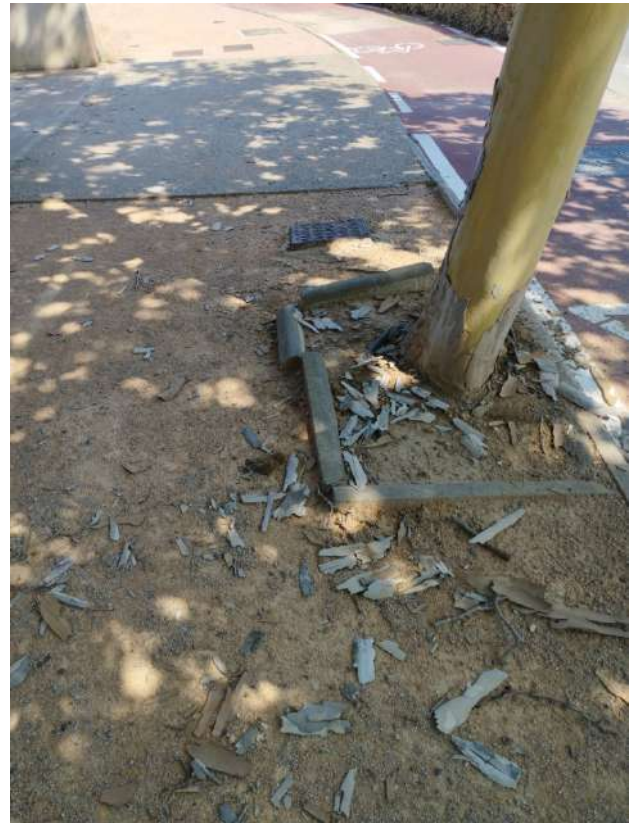
Alcorque tipo (a sustituir).
