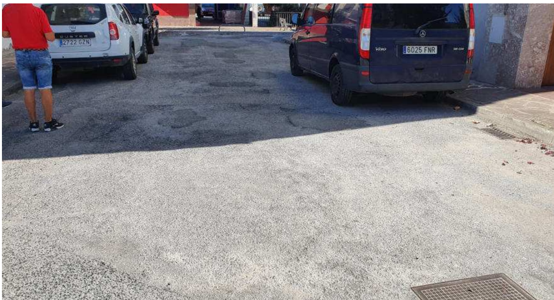
Fotografías de la vía Calle Santiago (Detrás del DIA)
