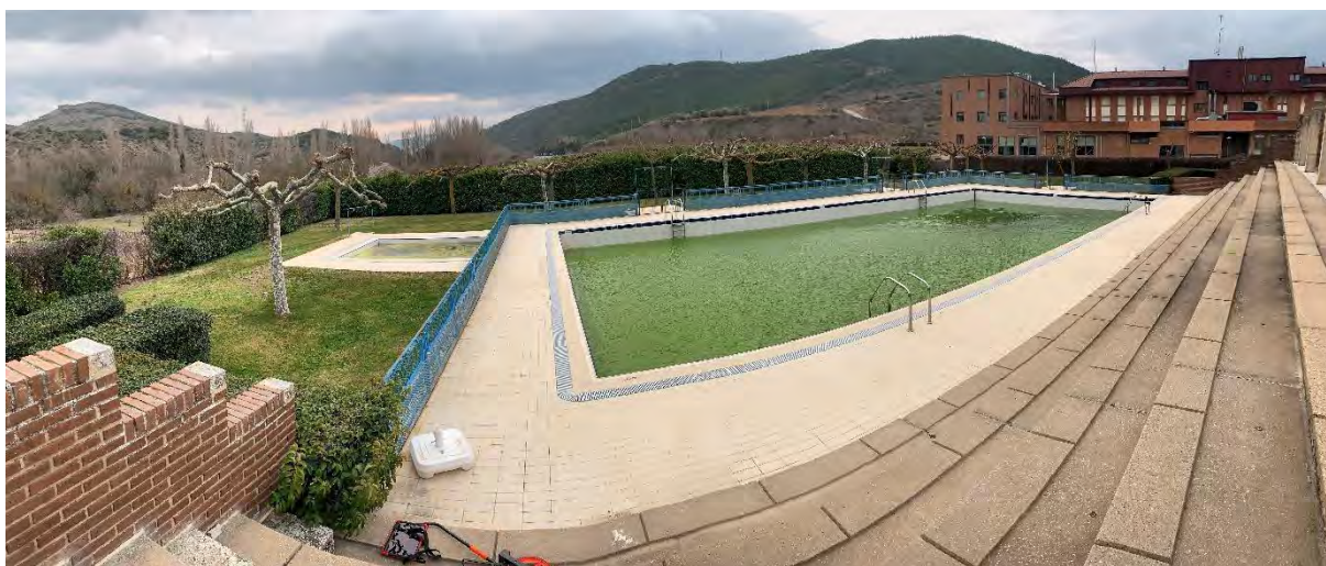
Vista general de los vasos. El vaso de chapoteo, a la izquierda, carece de playa en su frente oeste.
