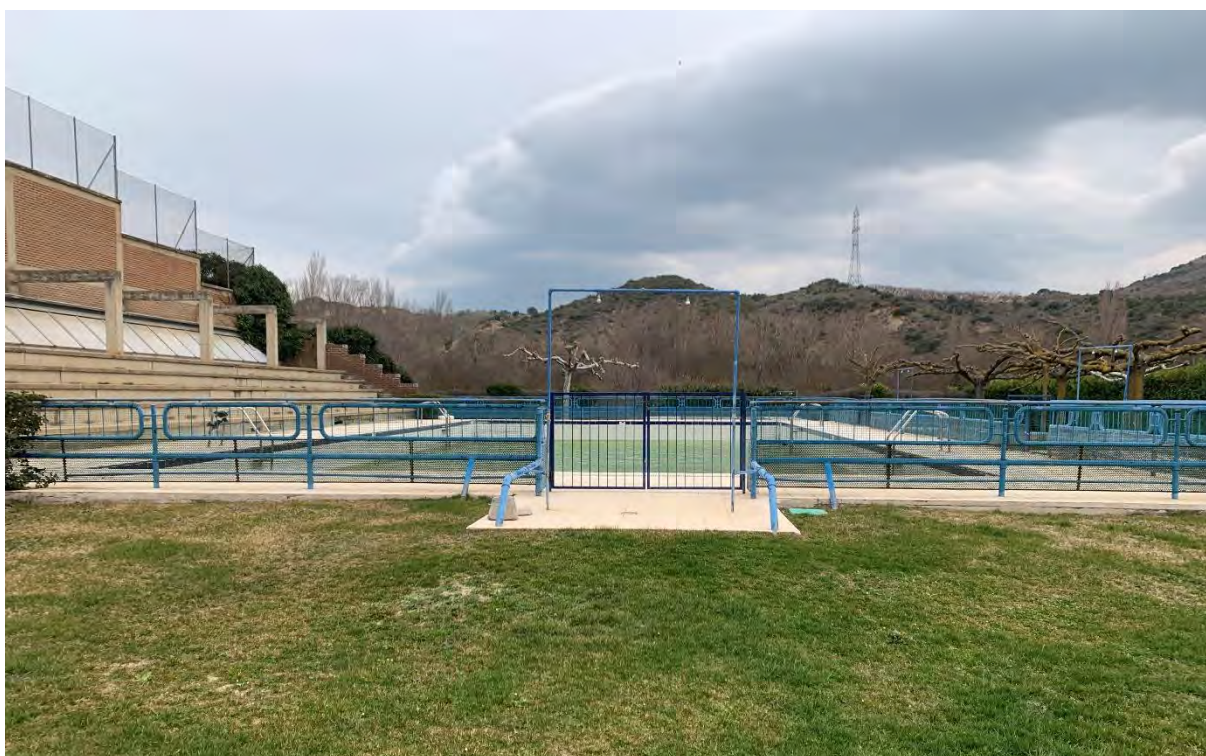
Vista del acceso a la piscina de recreo y de las barreras que la delimitan.
