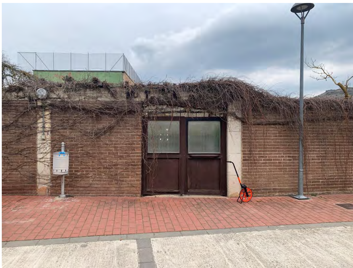
Acceso a las instalaciones por la calle Camino de Sangüesa nº 3 de Liédena.
