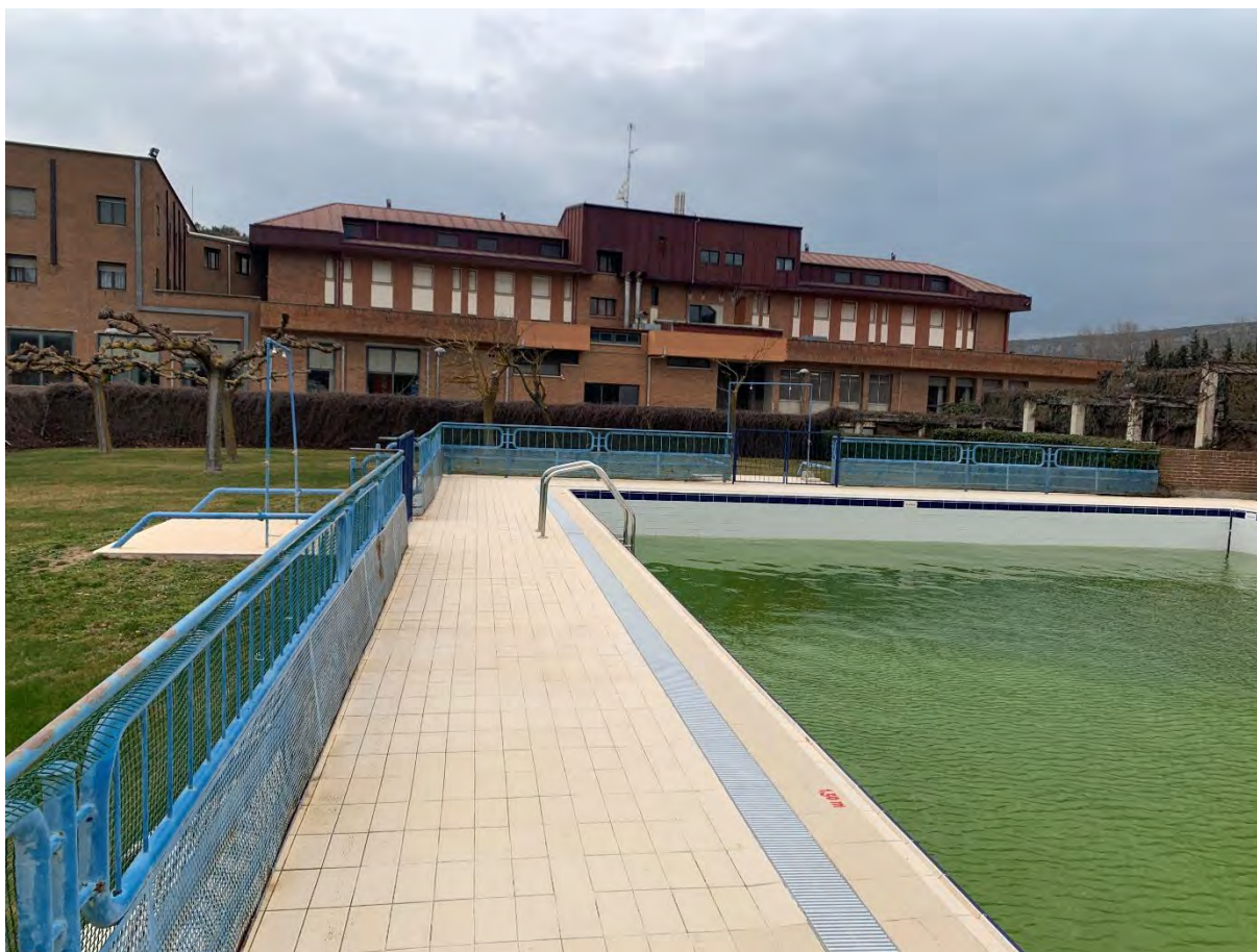
Detalle de las barreras revestidas con mallas para mejorar su seguridad.
