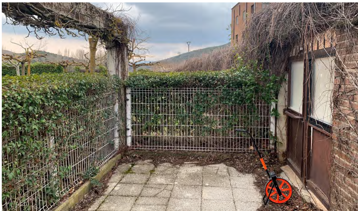
Entrada: se observa el deterioro de la puerta de acceso. El acceso accesible se propone a la izquierda, desmontando el cierre y eliminando el bordillo.
