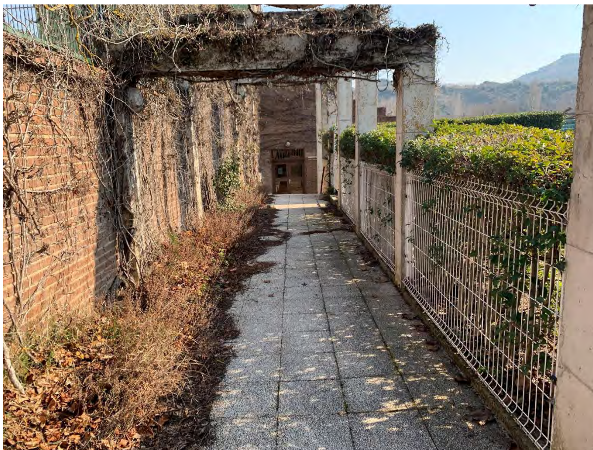
Entrada: se observa el deterioro de la puerta de acceso. El acceso accesible se propone a la izquierda, desmontando el cierre y eliminando el bordillo.
