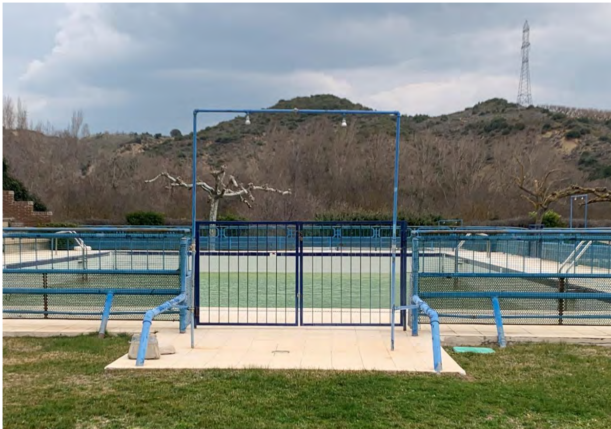
Detalle del pediluvio, duchas y cancelas de acceso al vaso.
