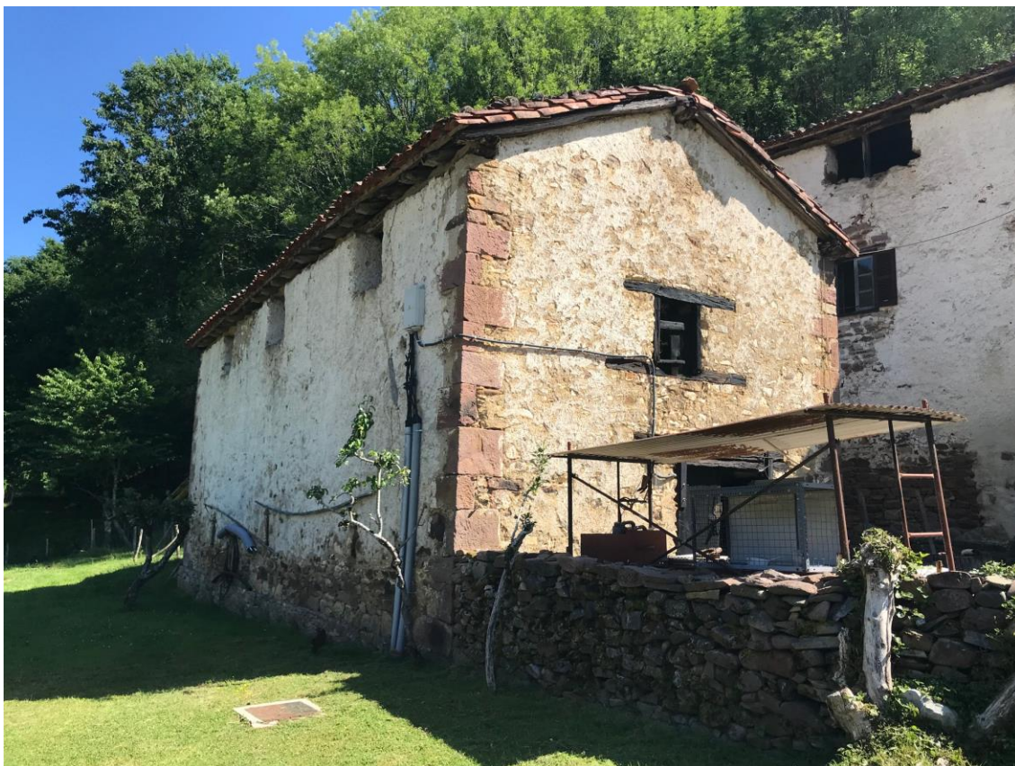
Abajo, edificio anexo
