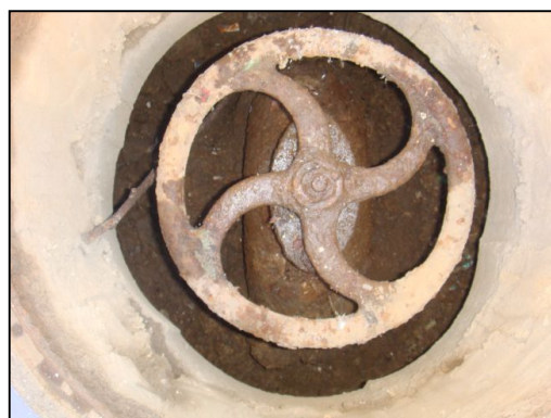
Conexión abast. Válvula 400 calle Frontón:
