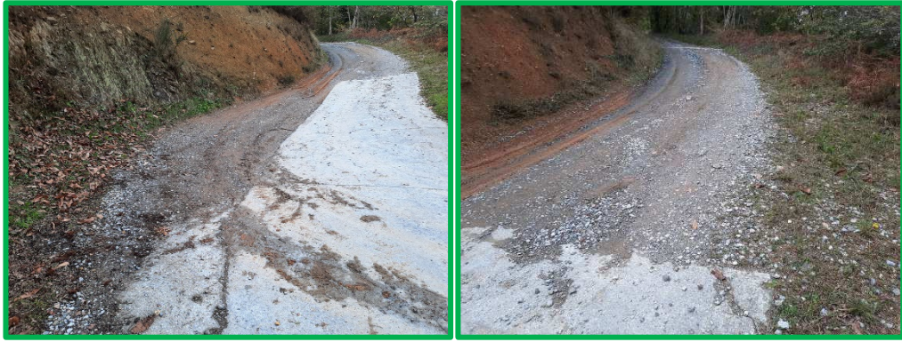
Fin del tramo hormigonado e inicio de la zona a hormigonar
