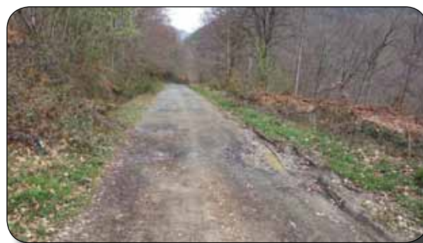
Tramos bacheados a reforzar y, abajo, situación de la cuneta
