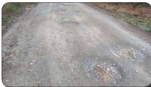
Tramos bacheados a reforzar y, abajo, situación de la cuneta
