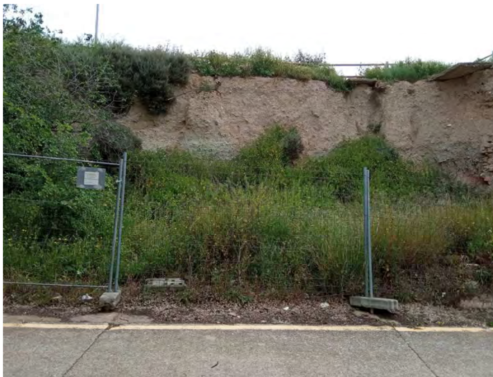
Vista general de la parcela 15, con el talud al fondo.
