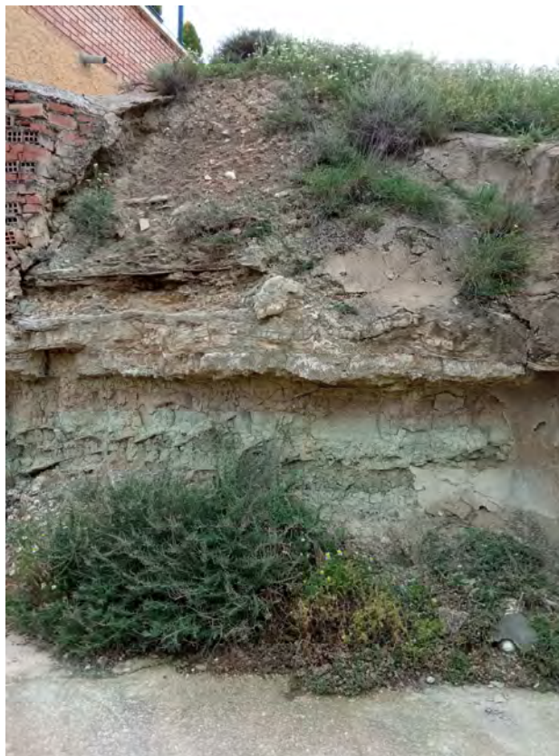
Talud afloramiento A3. Parcela 11.
