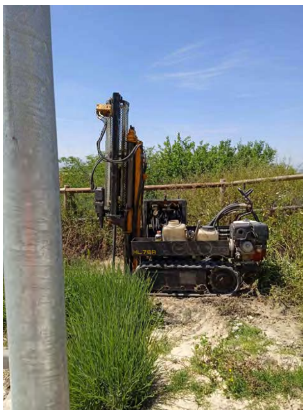
Ensayo de penetración dinámica P1.
