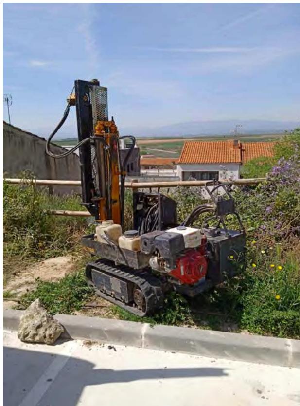
Ensayo de penetración dinámica P2.
