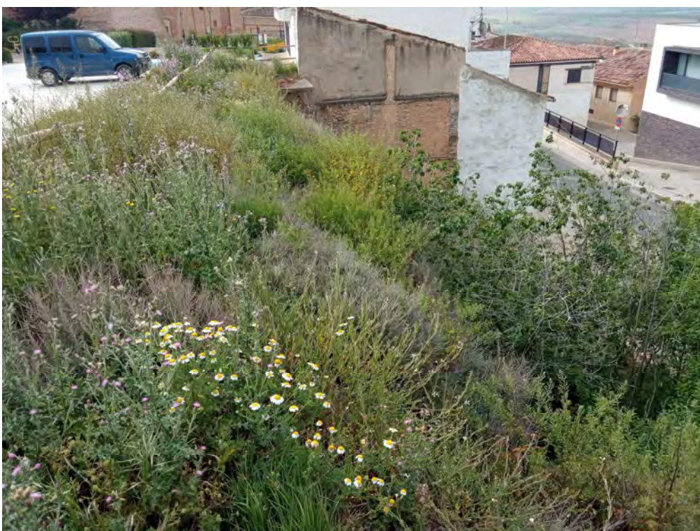
Vista hacia el este de la cabeza del talud.
