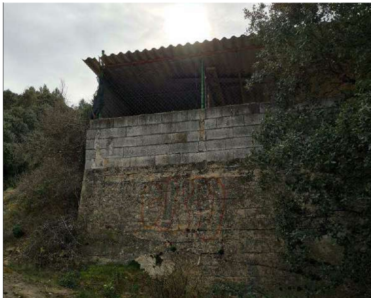
Ilustración 9. La edificación presenta una gran cimentación de la zona 7
