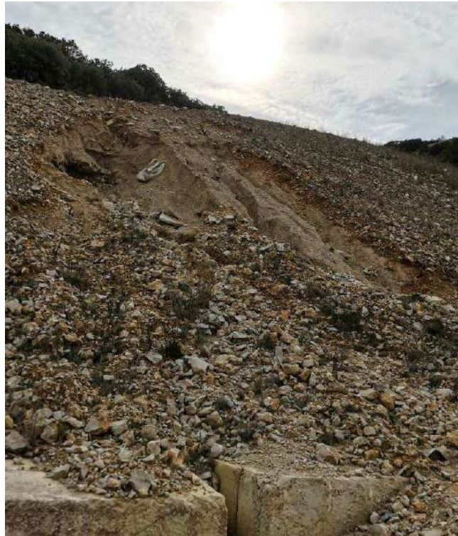
Ilustración 2. Zona 1 desprendida en que se realizarán labores de relleno
