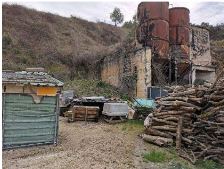
Ilustración 7. Edificación de la antigua cantera que deberá ser demolida de la zona 5
