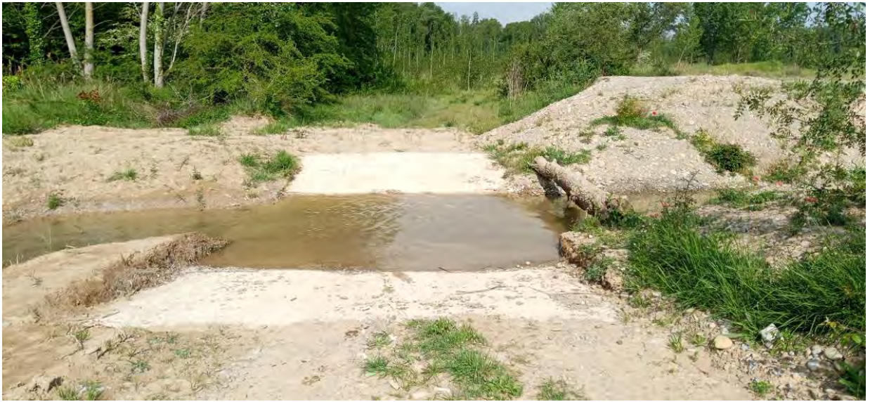
Sobrado actual de sistema de lagunas; vado a sustituir por nuevo aliviadero y paso camino
