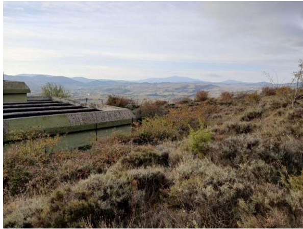
Ladera de ubicación de la ETAP y depósito
