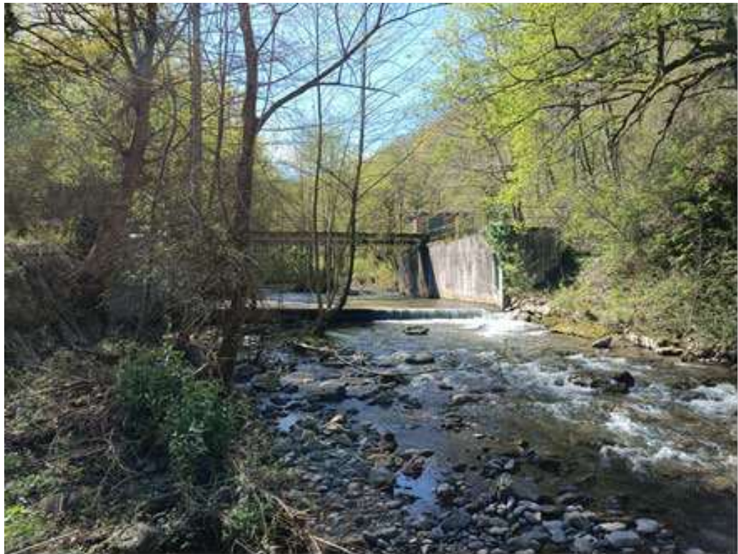
Foto 3: actual estación de aforos a demoler.
