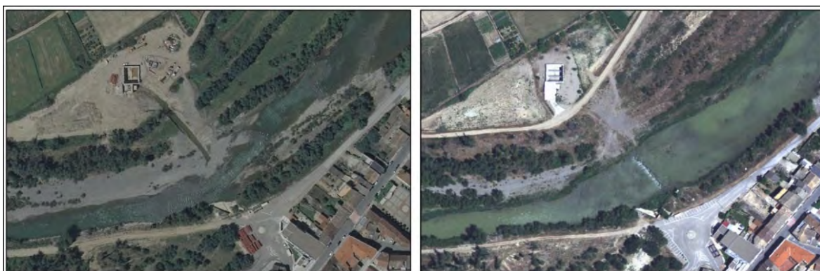
Estación de bombeo y toma en el Aragón, verano de 2008 (izq) y Azud en relación con ella (dcha)
