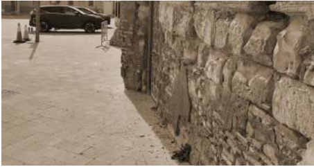
P2. ZÓCALO SILLERÍA EROSIONADO
