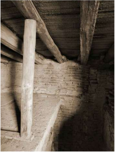
02. FOTOGRAFÍA DE CUBIERTA Y FORJADO SUELO
