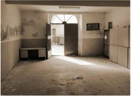
02. FOTOGRAFÍA INTERIOR ANTIGUA ACCESO A IGLESIA
