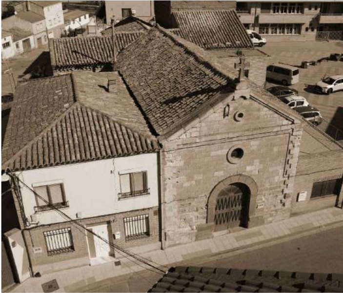
FOTOGRAFÍA DE FACHADAS SUR
