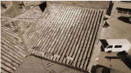
03. FOTOGRAFÍA DE CUBIERTA
