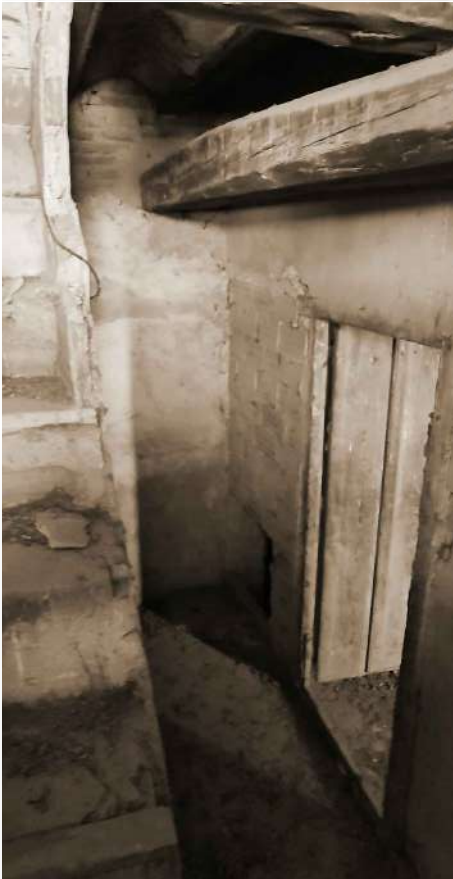
01. FOTOGRAFÍA DE NÚCLEO DE ESCALERAS
