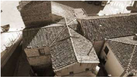
04. FOTOGRAFÍA DE CUBIERTAS SOBRE BÓVEDAS DE P1
