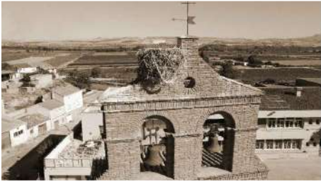
05. FOTOGRAFÍA DE ESPADAÑA EN SU ESTADO ACTUAL
