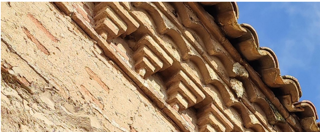
Alero tejazoz en crujía Este cara Sur. Cornisa y alero sobre tapial calicostrado con ladrillo.
