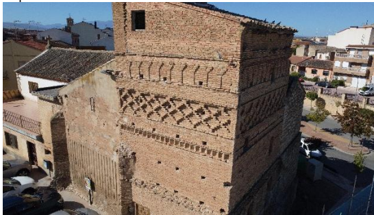
Torre. Esquina noreste.
