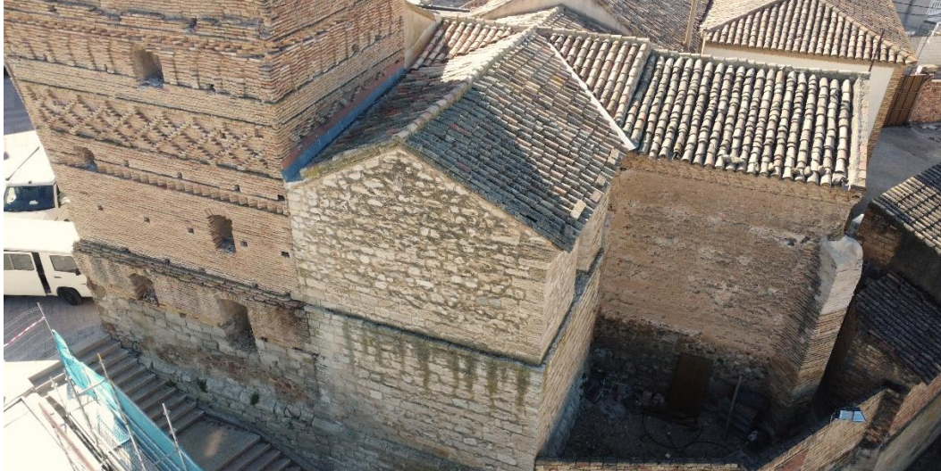
Imagen de la fachada norte del conjunto
