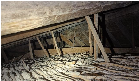
Bajo cubierta de la nave central
