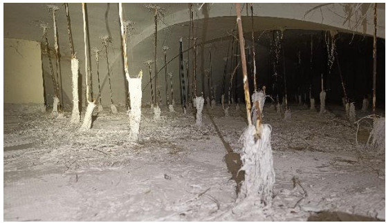
Falso techo entre el aula y las bóvedas de la nave central
