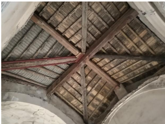
Cubierta del crucero en la Nave original
