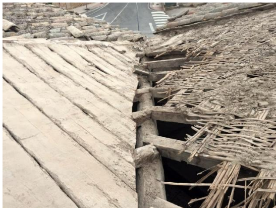
Rehabilitación de cubierta en 2023
