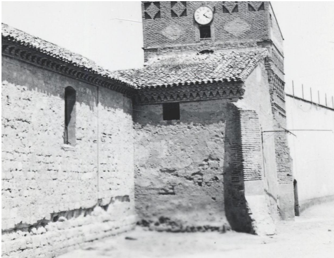
Cara Sur de la crujía este en la Nave original. Presencia de alero de configuración común en toda la nave.
