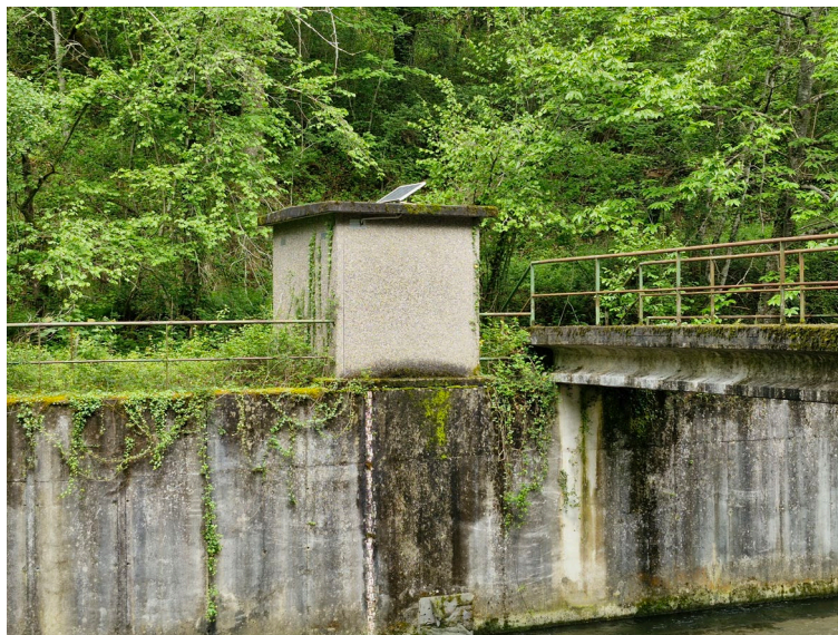
Muros de hormigón armado y vigas de paso pretensadas en estación de aforo existente
