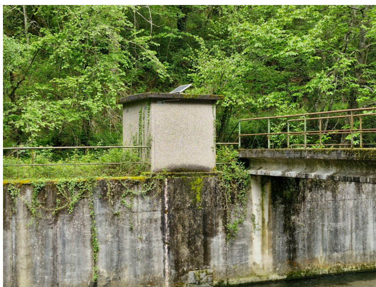
Muros de hormigón armado y vigas de paso pretensadas en estación de aforo existente
