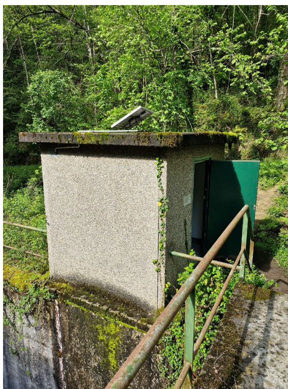
Caseta de hormigón y valla metálica en estación de aforo actual
