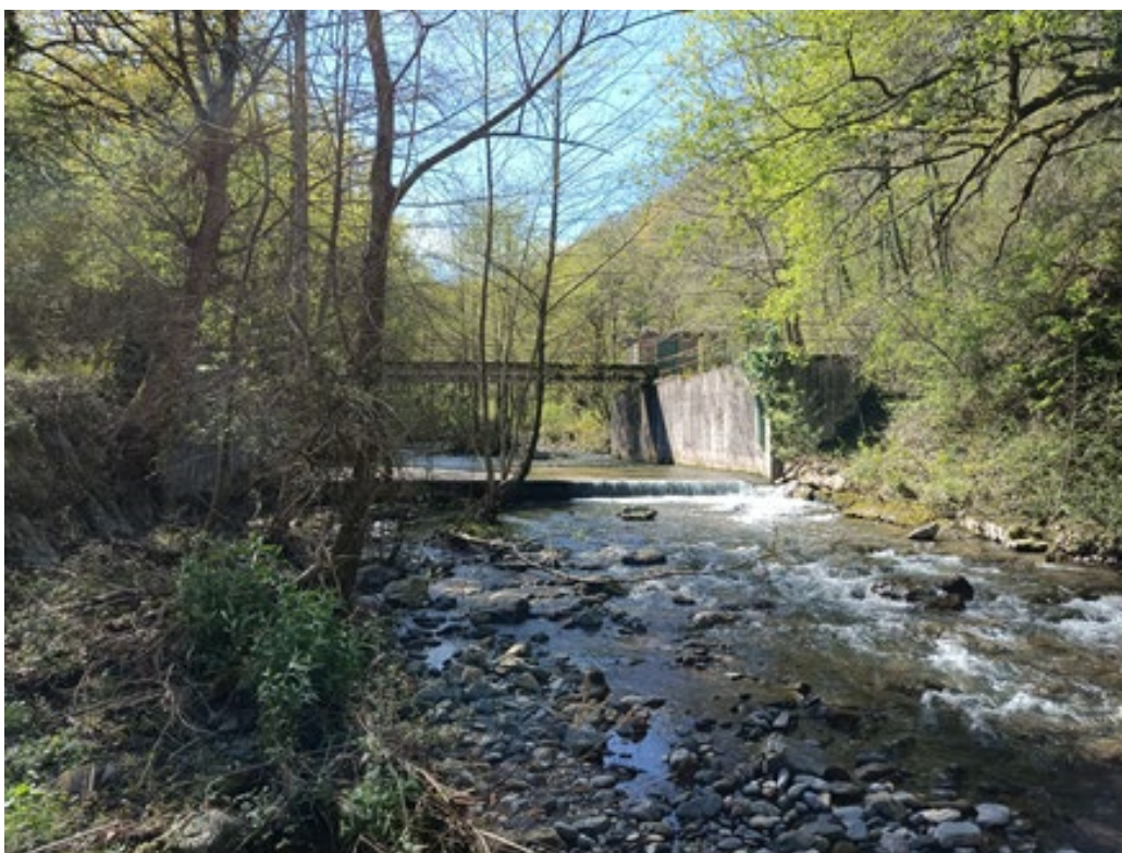
Foto 3: actual estación de aforos a demoler.
