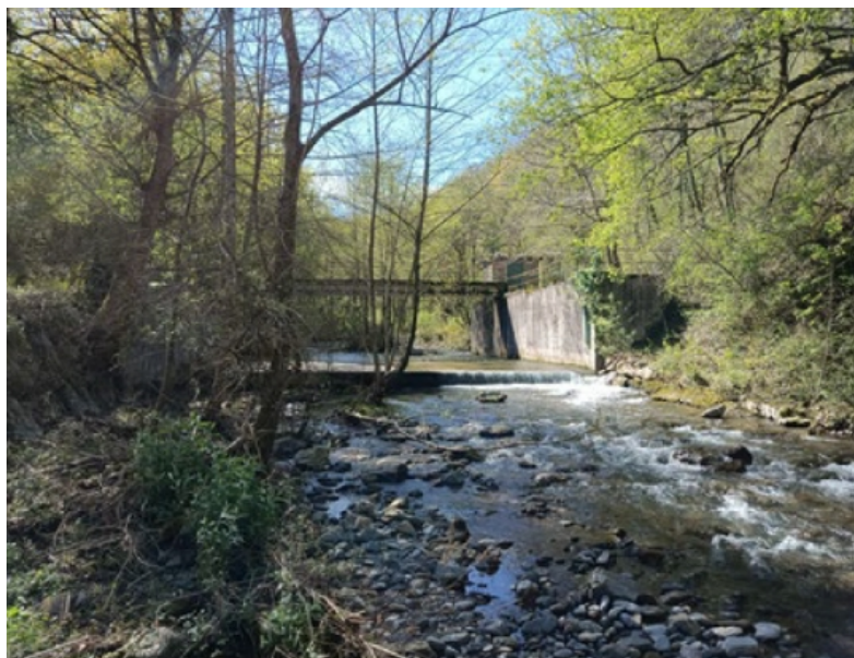
Imagen 2. Estación de aforo actual desde aguas abajo
