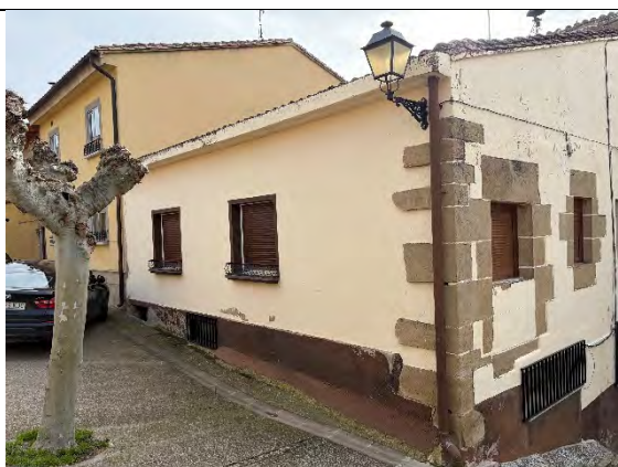
Foto 07: Fachada oeste y norte
