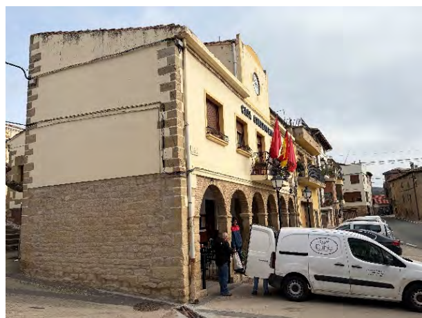
Foto 03: Fachada sur y oeste
