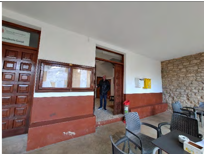
Foto 02: Porche acceso a edificio
