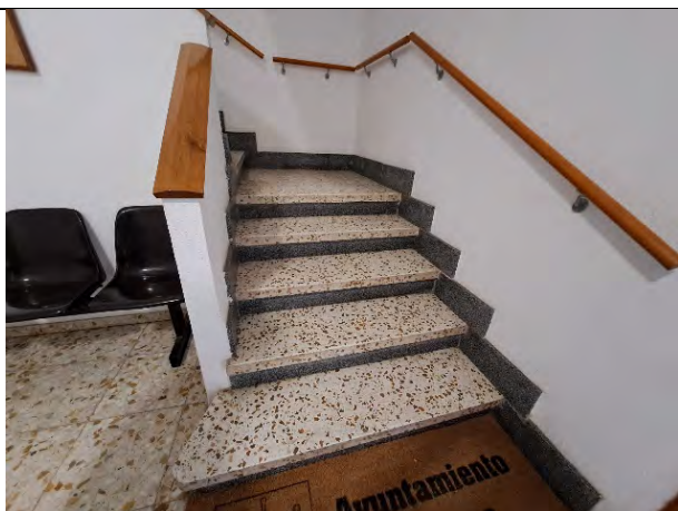
Foto 05: Escalera de acceso a planta 1ª
