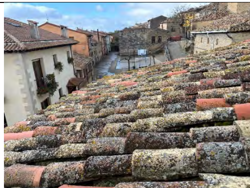
Foto 12: Cubierta del edificio
