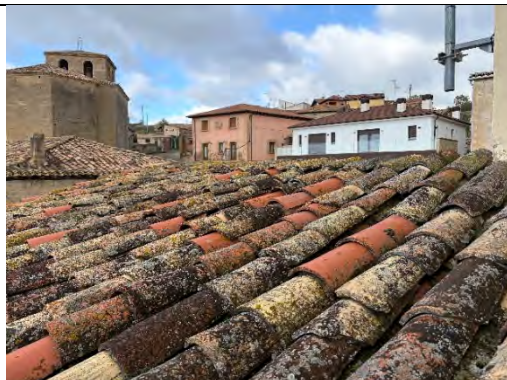
Foto 11: Cubierta del edificio
