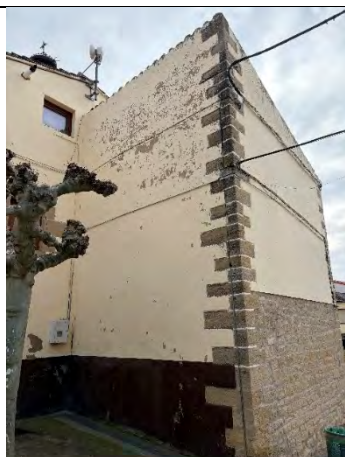
Foto 05: Fachada oeste y norte
