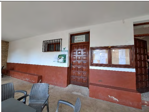
Foto 01: Porche acceso a edificio
