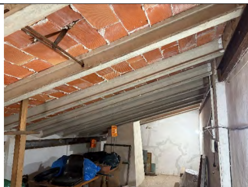
Foto 10: Entrecubierta transitable (almacén)
