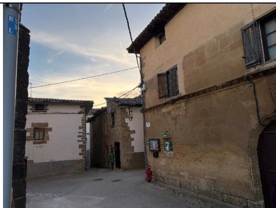
Foto 2: Cubierta Fachada este
