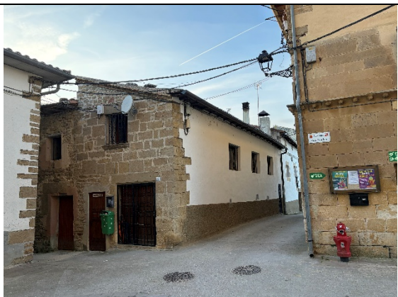
Foto 1: Cubierta Fachada este
