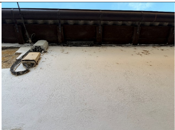
Foto 3: Alero cubierta Fachada este
