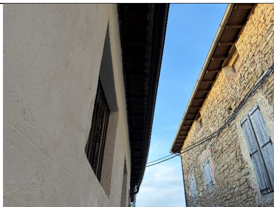
Foto 4: Alero cubierta Fachada este
