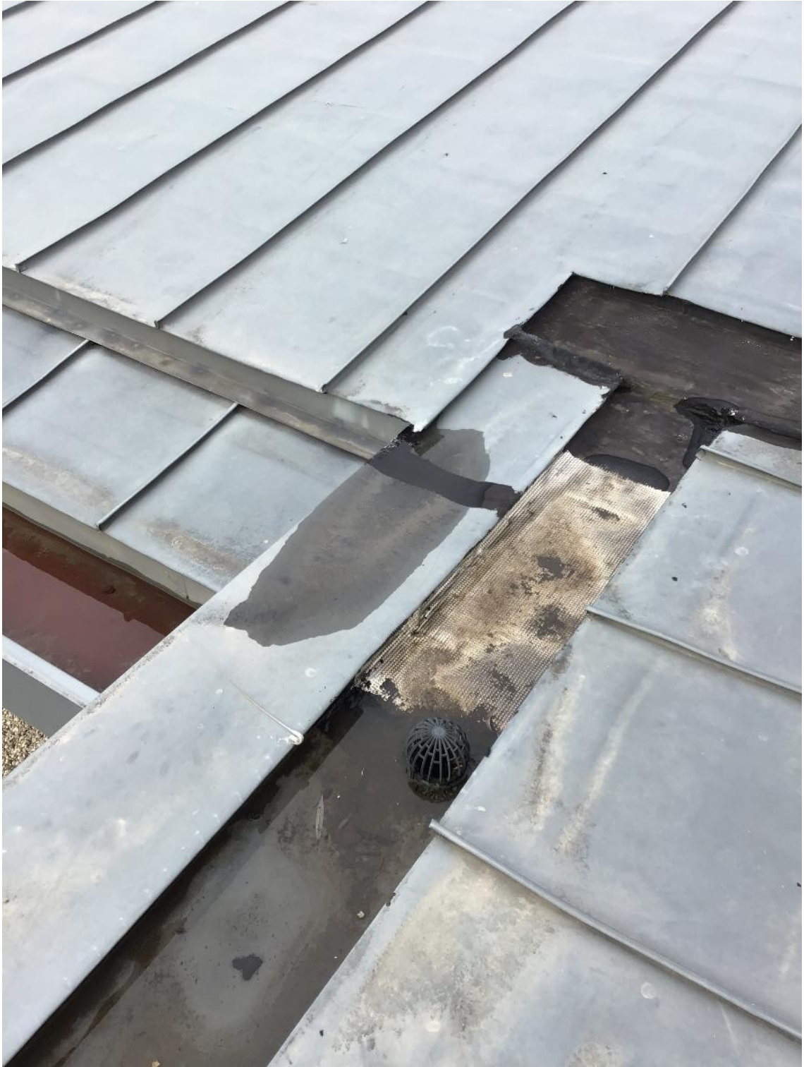
Sellados y reparaciones de urgencia
