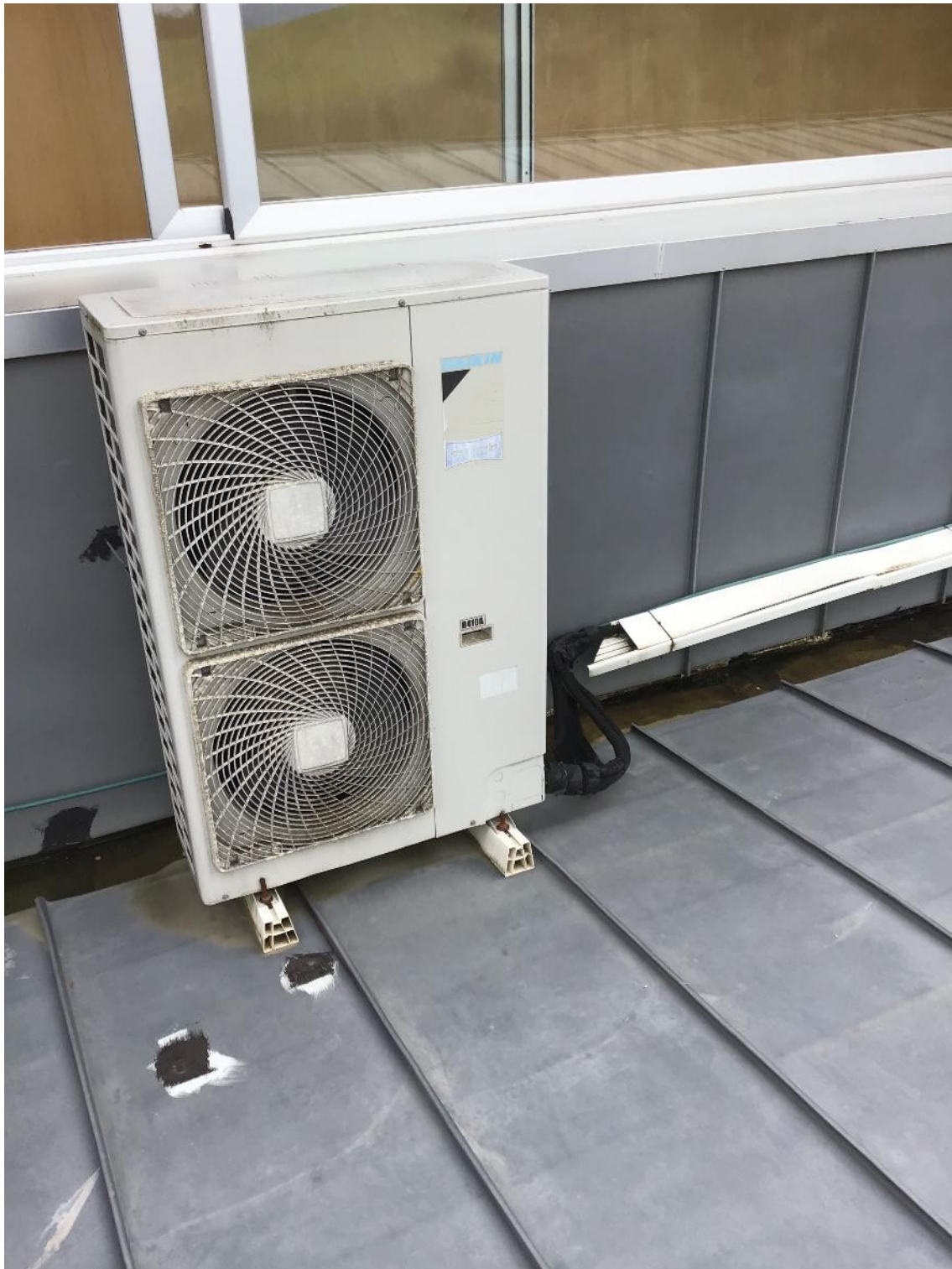
Instalación de equipos de refrigeración
