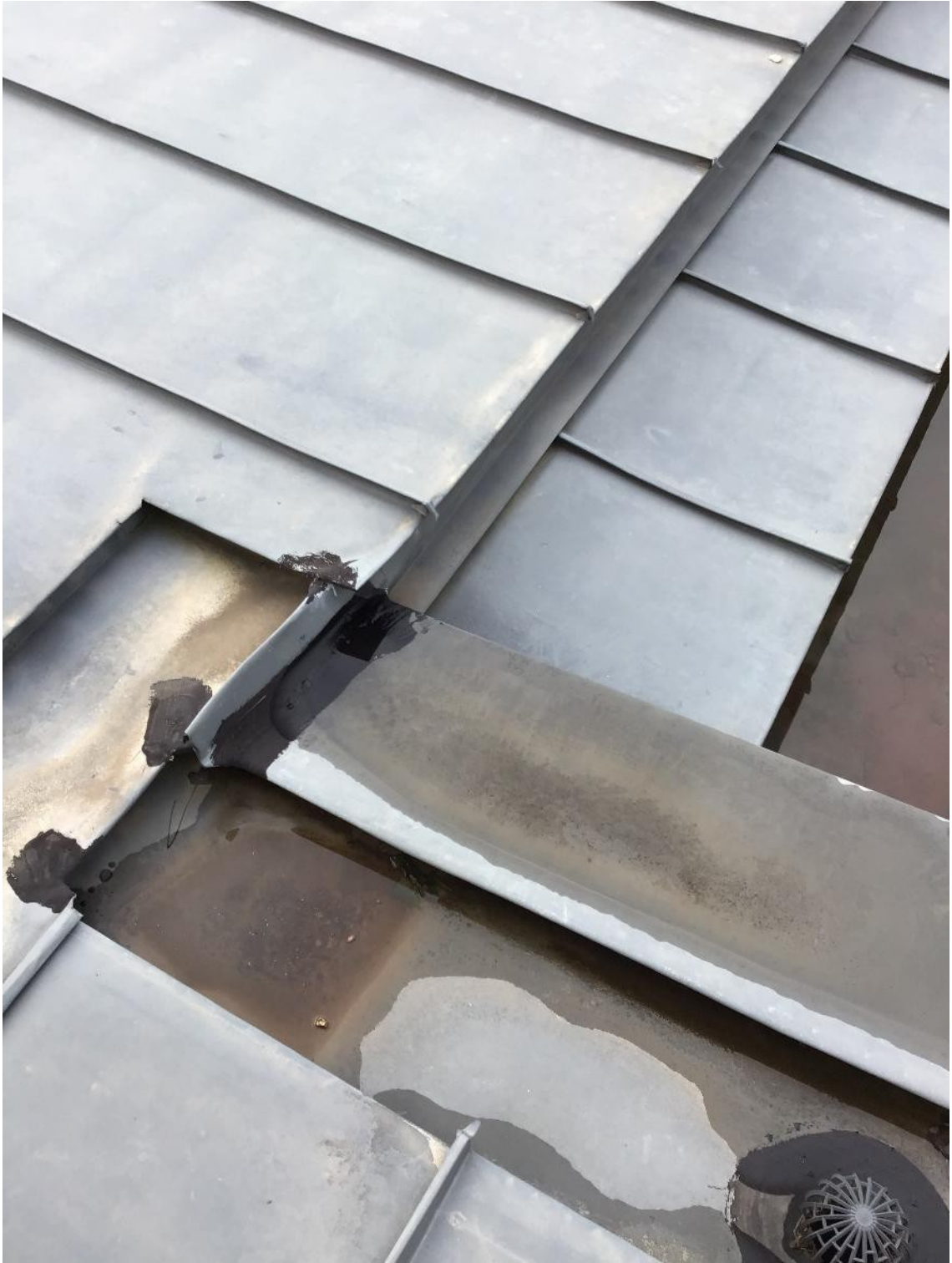
Sellados y reparaciones de urgencia
