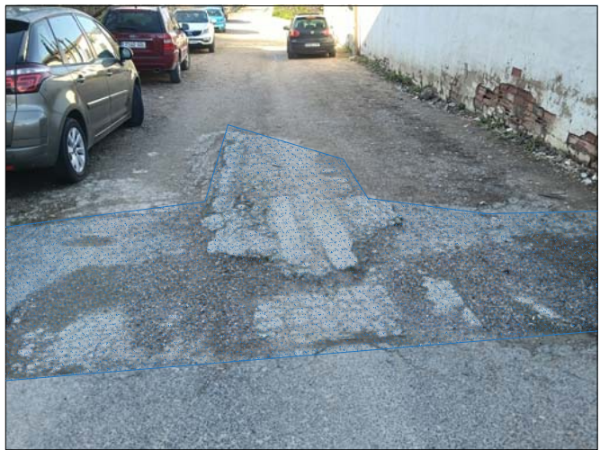
RETIRADA DE HORMIGÓN
