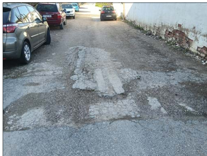
INICIO TRAMO DE CAMINO SIN ASFALTAR
