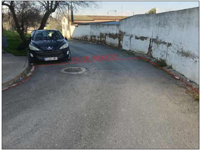
FIN DE FRESADO DE ASFALTO
