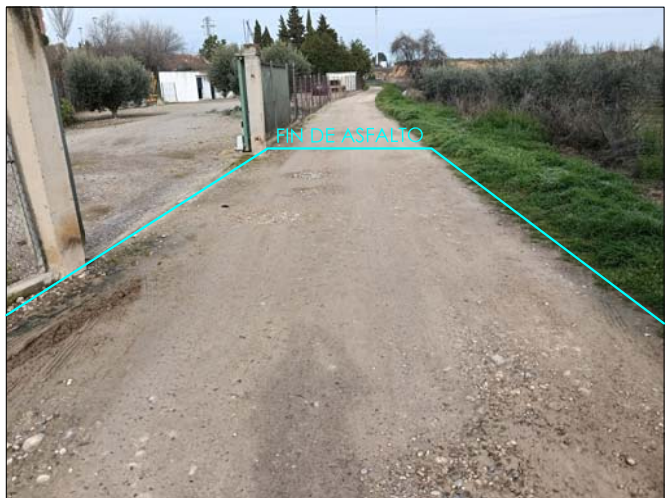
FINALIZACIÓN DEL TRAMO A ASFALTAR
