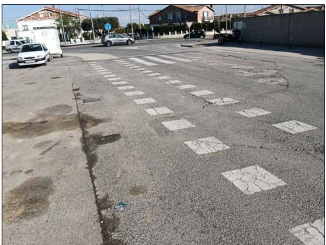
LÍMITE DEL TRAMO A ASFALTAR CON LA GASOLINERA
