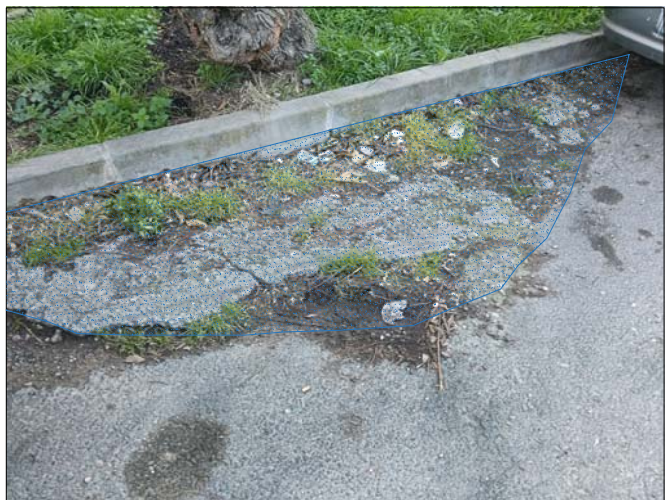
RETIRADA DE HORMIGÓN
