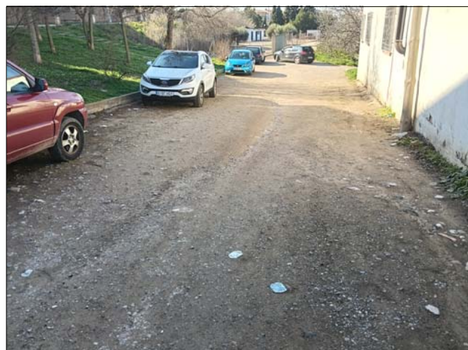
TRAMO DE CAMINO SIN ASFALTAR
