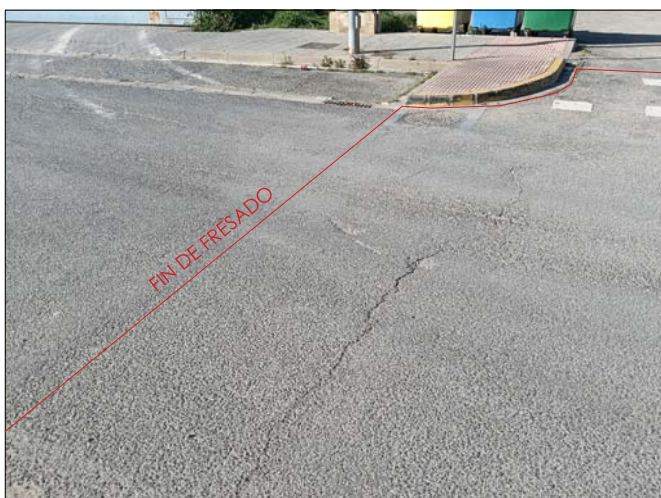
FINALIZACIÓN DEL TRAMO A ASFALTAR
