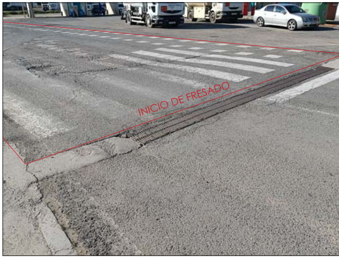
INICIO FRESADO DE ASFALTO
