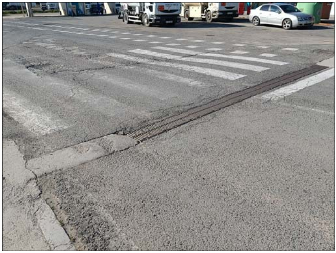
INICIO DE TRAMO A ASFALTAR
