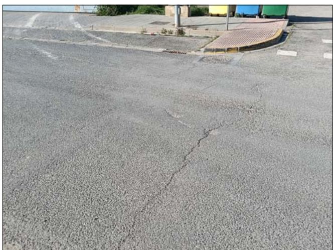
FINALIZACIÓN DEL TRAMO A ASFALTAR
