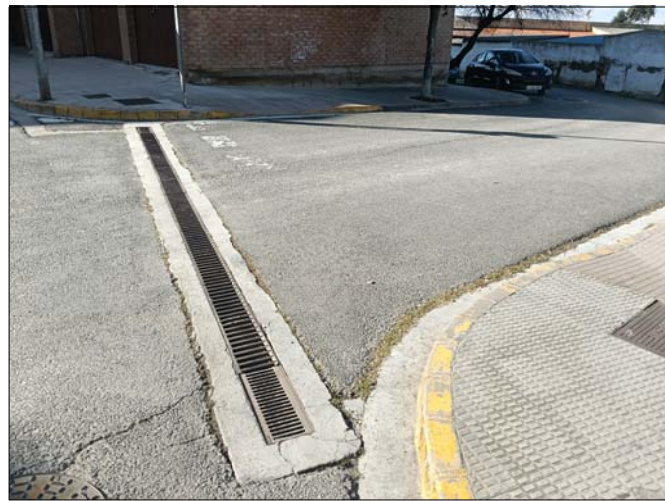
INICIO DE CAMINO EN C/ LAUREL ASFALTADO
