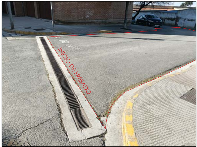
INICIO FRESADO DE ASFALTO
