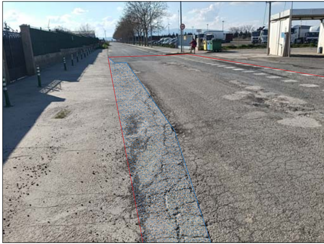
FRESADO DE HORMIGON EN LÍMITE CON PARCELAS
