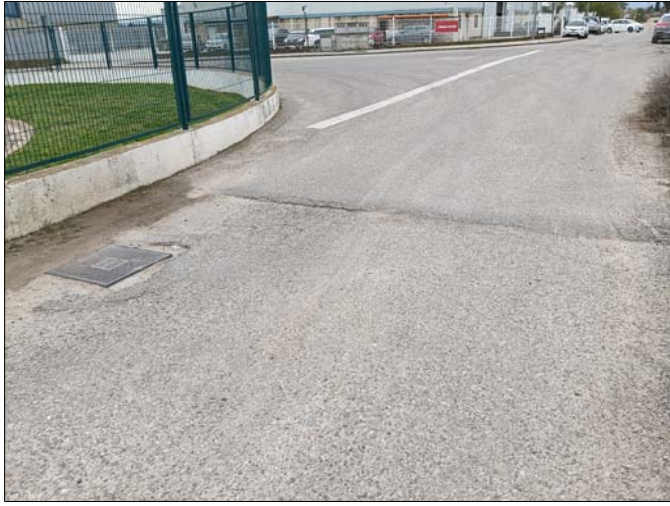
TRAMO DE VIAL A ASFALTAR
