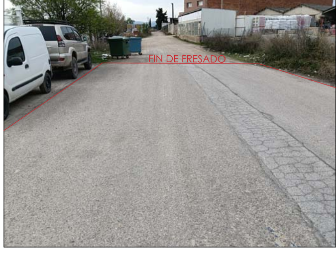
FIN DE TRAMO A ASFALTAR
