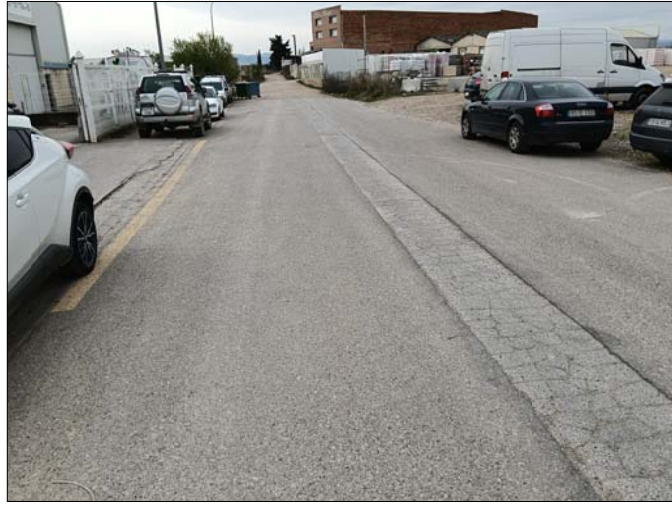
FINAL DE VIAL A ASFALTAR
