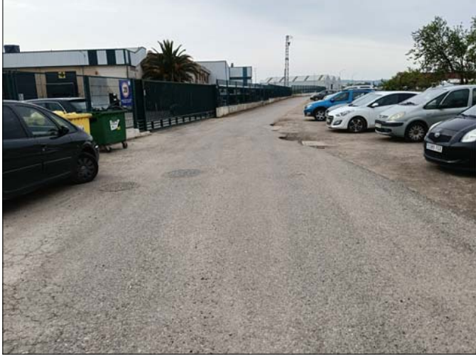
TRAMO DE VIAL A ASFALTAR
