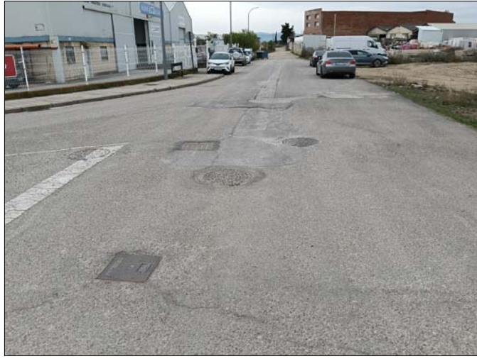
TRAMO DE VIAL A ASFALTAR
