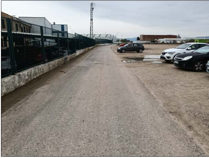
TRAMO DE VIAL A ASFALTAR
