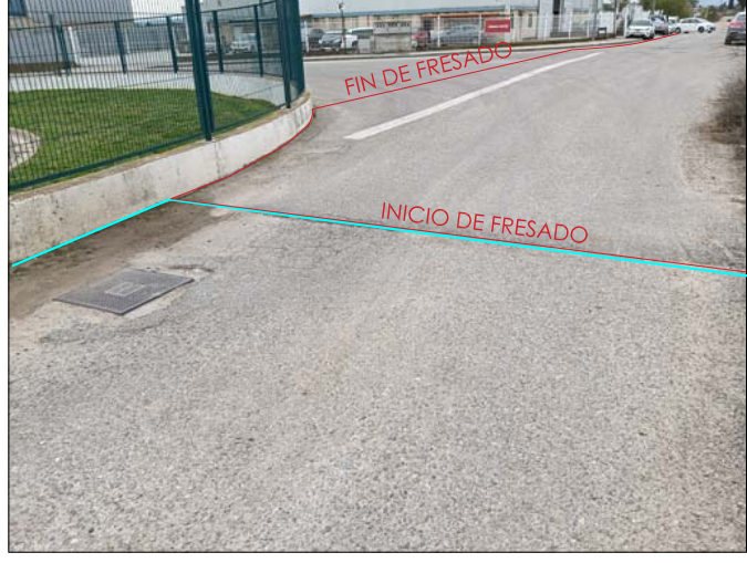
TRAMO DE VIAL A ASFALTAR
