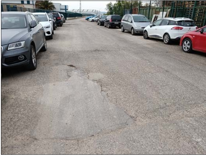
TRAMO DE VIAL A ASFALTAR
