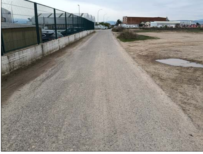
TRAMO DE VIAL A ASFALTAR
