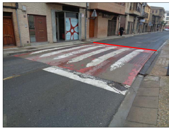
① CORTE INICIO FRESADO
