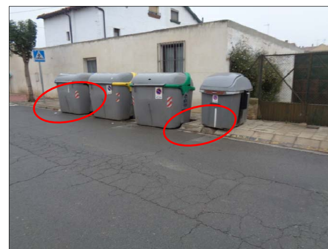
⑮ AMPLIACIÓN ZONA CONTENEDORES
