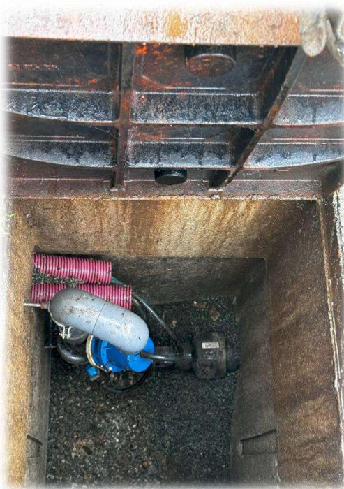
Fotografía 4 – Arqueta de succión existente.
