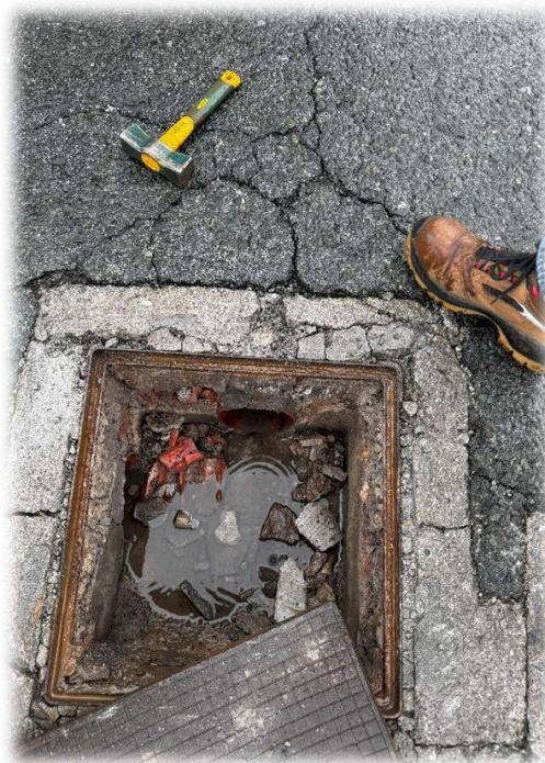
Fotografía 7 –Arqueta de canalización afectada por el proyecto.
