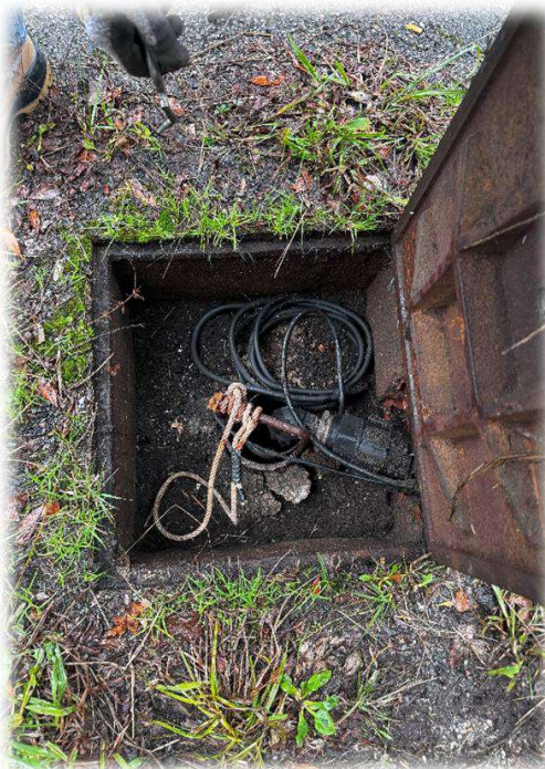
Fotografía 9 – Arqueta de canalización afectada por el proyecto.
