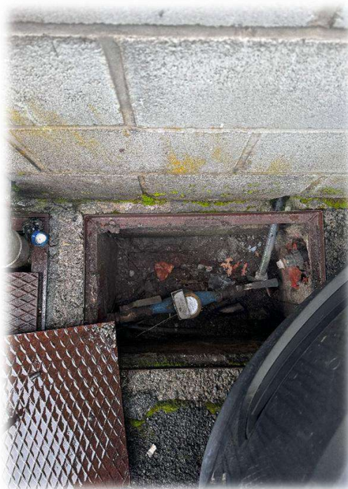
Fotografía 5 – Acometida de abastecimiento de industria afectada por el proyecto.
