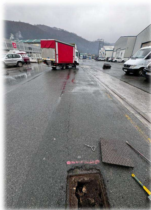
Fotografía 8 – Vista general de arqueta de canalización afectada por el proyecto.
