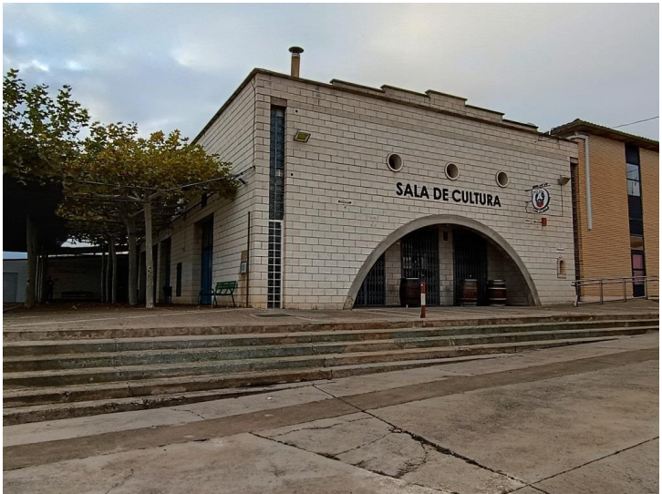
Foto estado actual fachada principal
