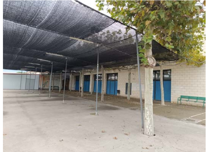
Vista fachada lateral.
