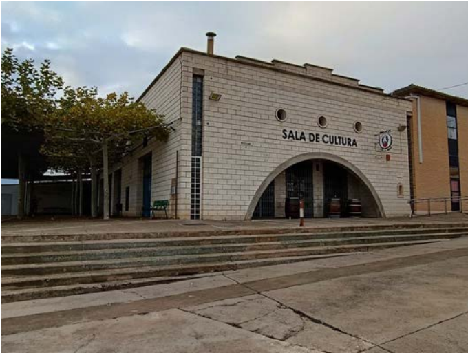
Vista exterior edificio.
