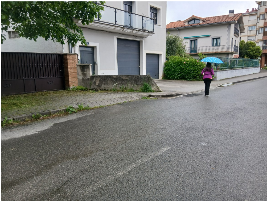
FOTOGRAFÍA 8. AMPLAICIÓN ACERA GRUPO SAN PEDRO
