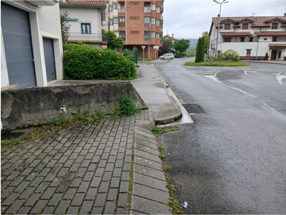
FOTOGRAFÍA 5. AMPLAICIÓN ACERA GRUPO SAN PEDRO
