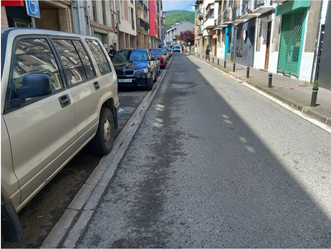
FOTOGRAFÍA 1. ASFALTADO CALLE SAN JUAN
