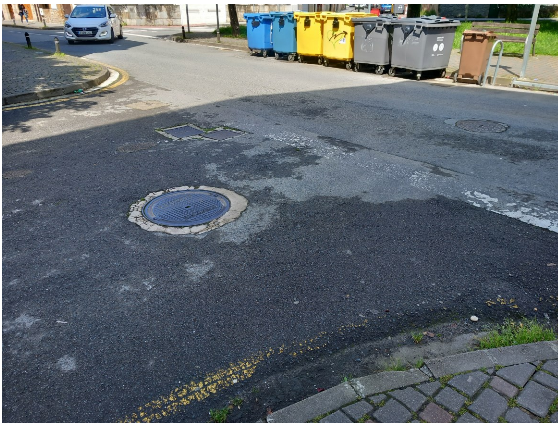
FOTOGRAFÍA 11. ASFALTADO CALLE SAN JUAN
