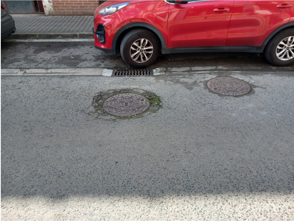
FOTOGRAFÍA 5. ASFALTADO CALLE SAN JUAN
