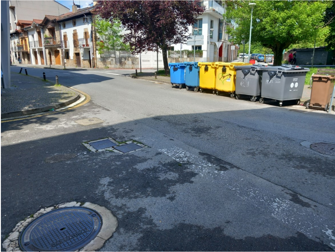
FOTOGRAFÍA 9. ASFALTADO CALLE SAN JUAN
