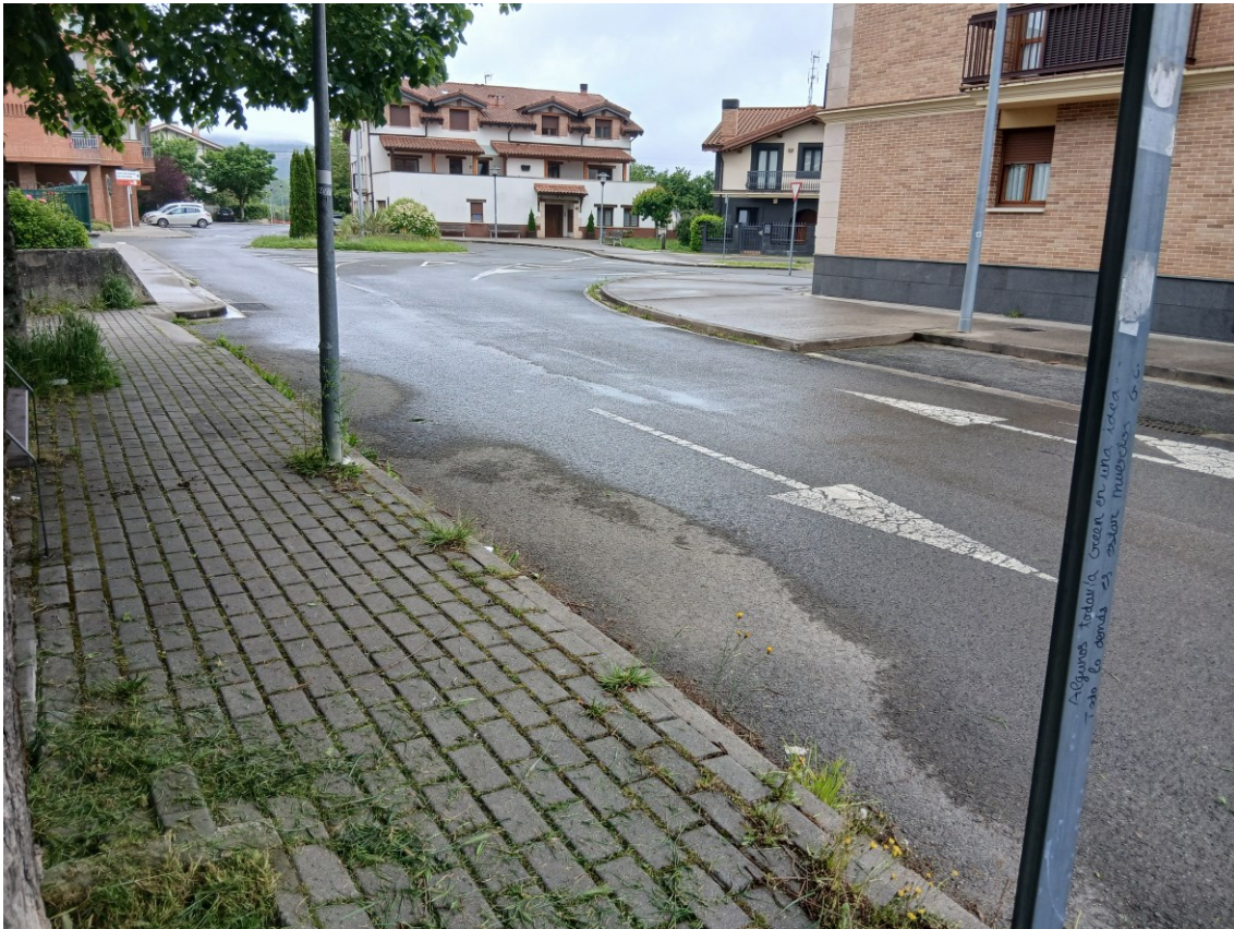
FOTOGRAFÍA 4. AMPLAICIÓN ACERA GRUPO SAN PEDRO
