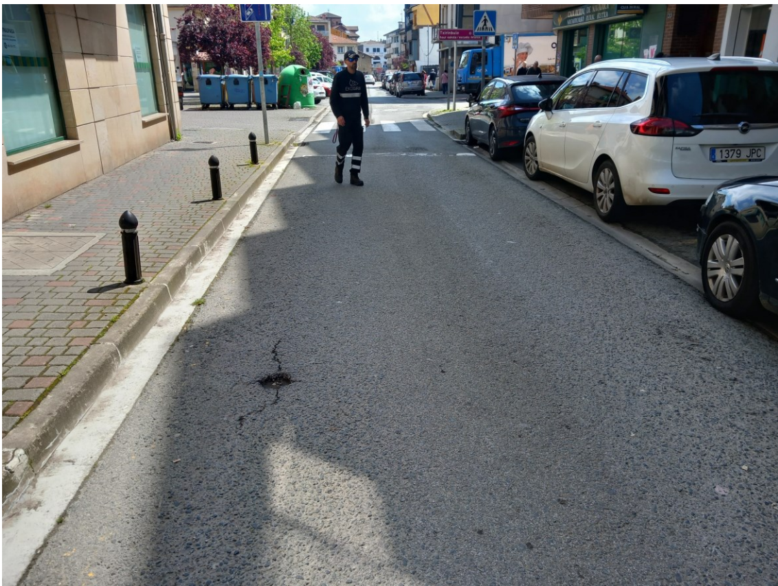
FOTOGRAFÍA 2. ASFALTADO CALLE SAN JUAN
