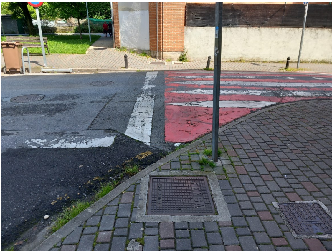
FOTOGRAFÍA 12. ASFALTADO CALLE SAN JUAN
