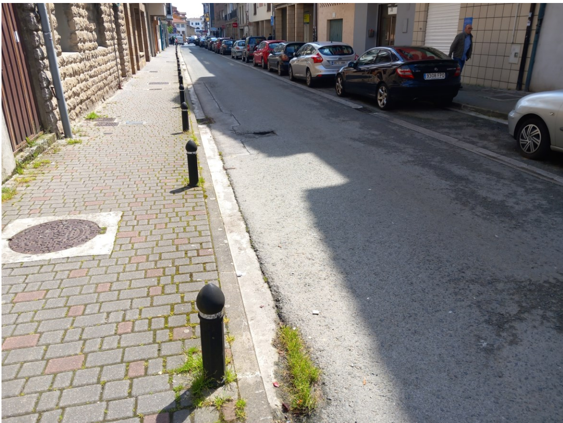
FOTOGRAFÍA 8. ASFALTADO CALLE SAN JUAN
