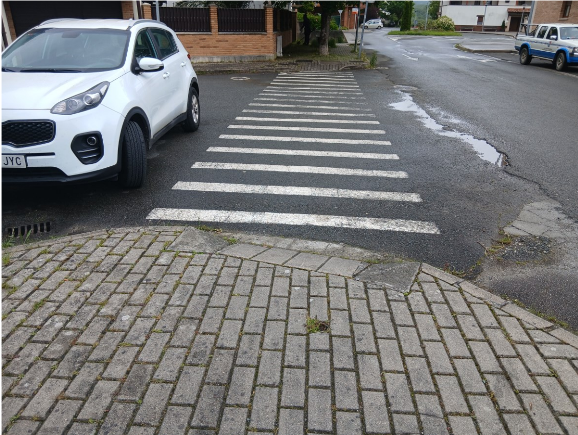
FOTOGRAFÍA 1. AMPLAICIÓN ACERA GRUPO SAN PEDRO
