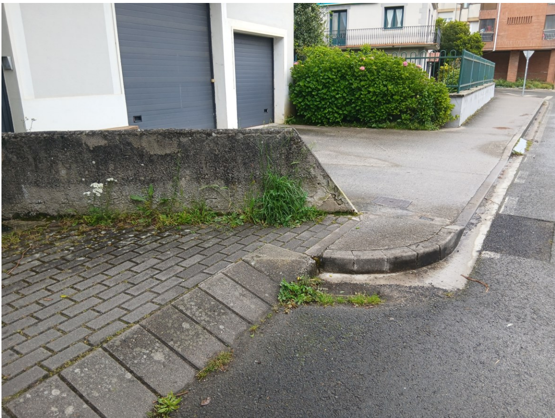
FOTOGRAFÍA 6. ASFALTADO CALLE SAN JUAN
