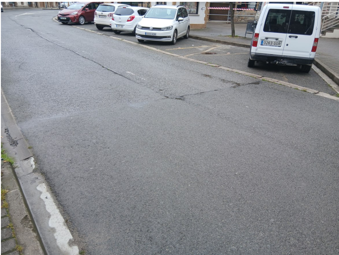
FOTOGRAFÍA 4. ACERAS Y PASO ELEVADO ZELAI TXIKI
