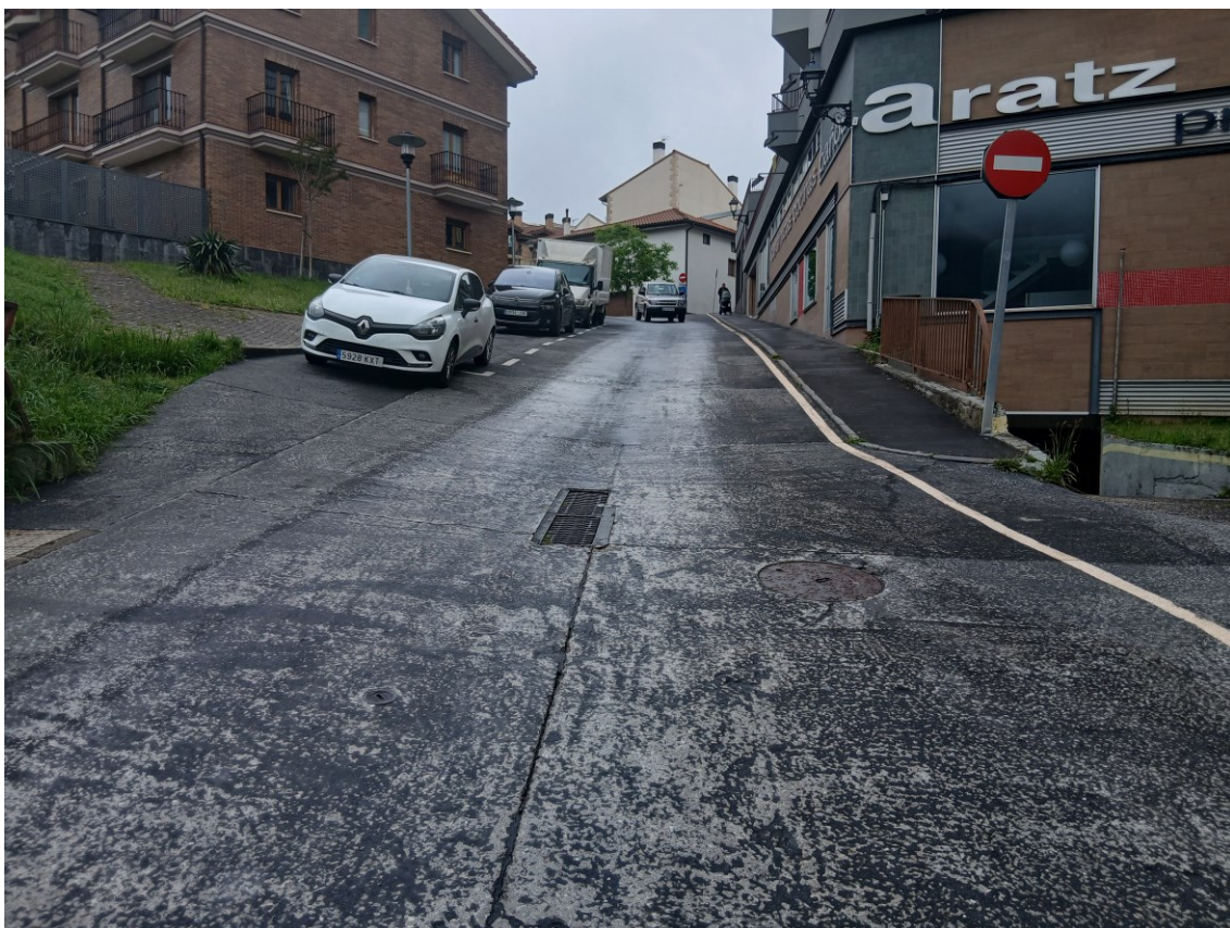
FOTOGRAFÍA 4. CALLE GARCÍA XIMÉNEZ / CALLE SORGINGAINBERA
