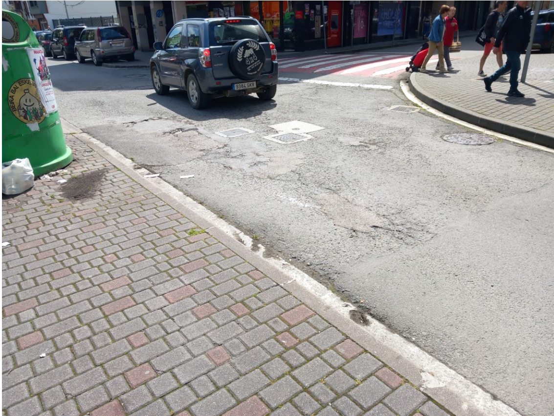
FOTOGRAFÍA 3. ASFALTADO CALLE SAN JUAN
