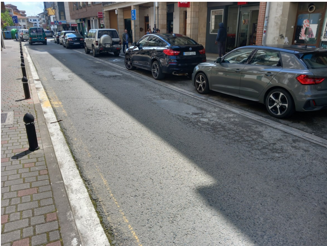
FOTOGRAFÍA 6. ASFALTADO CALLE SAN JUAN
