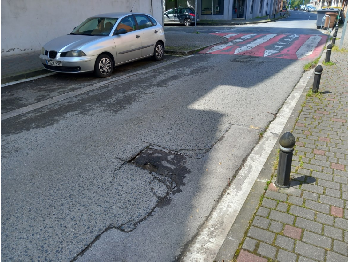
FOTOGRAFÍA 7. ASFALTADO CALLE SAN JUAN
