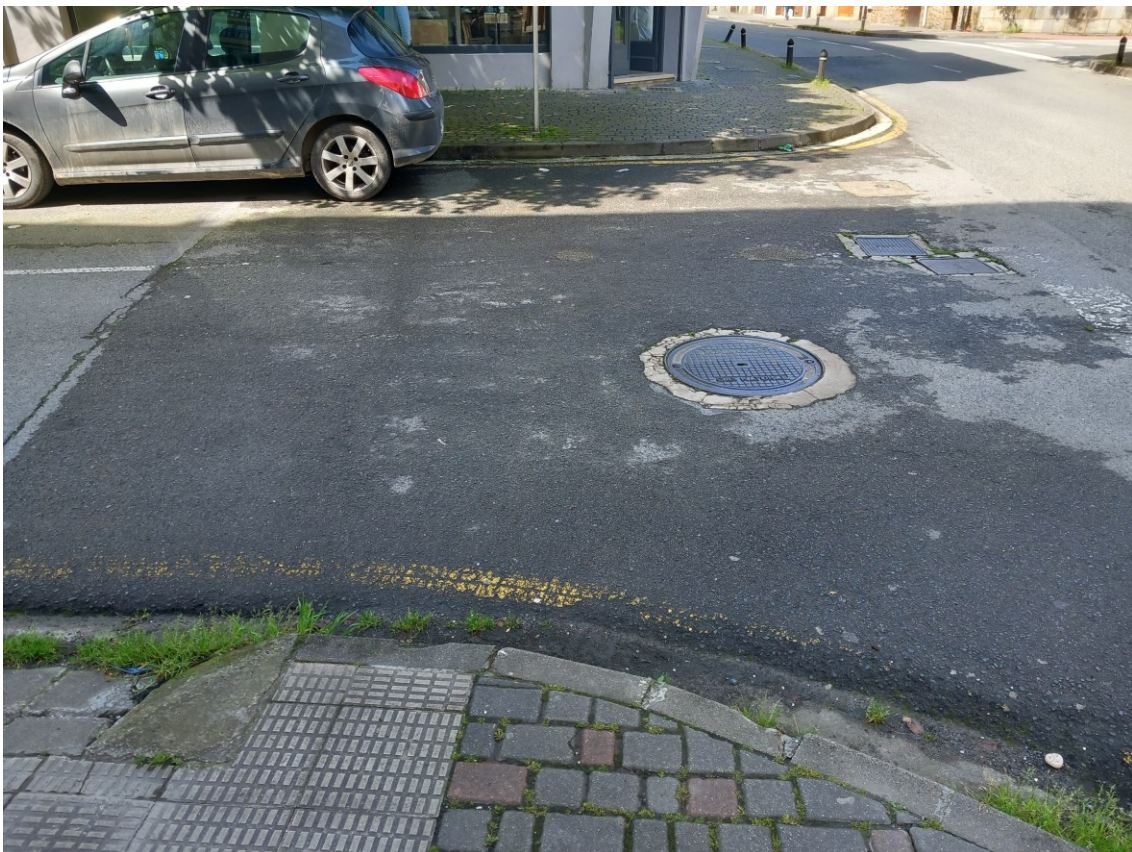
FOTOGRAFÍA 10. ASFALTADO CALLE SAN JUAN
