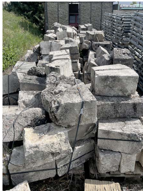
02. Vista General de Acopio de Sillares y Dovelas.
