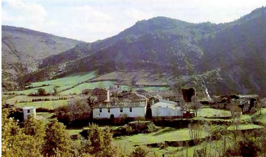
02. Vista del conjunto del Poblado de Orbaiz previa a la construcción del Embalse de Itoiz.
