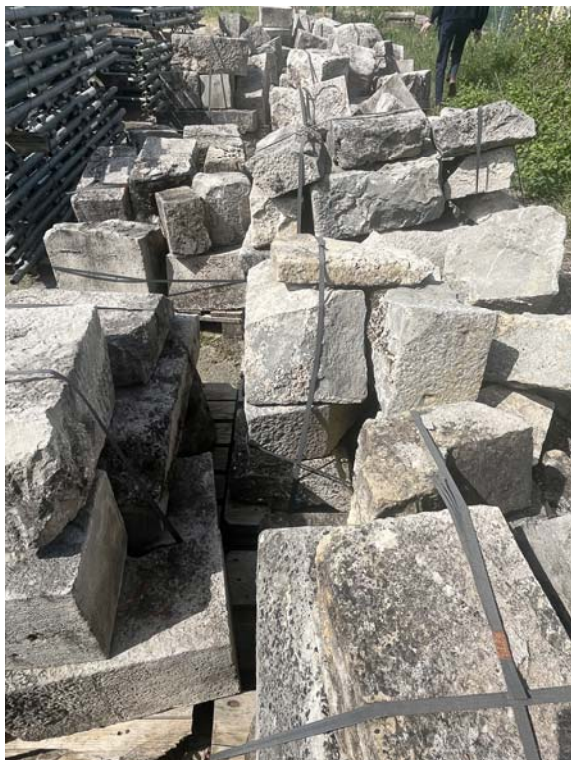
01. Vista General de Acopio de Sillares y Dovelas.
