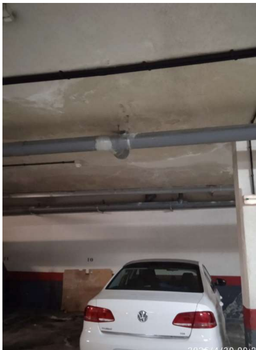
Antes de la prueba de agua
