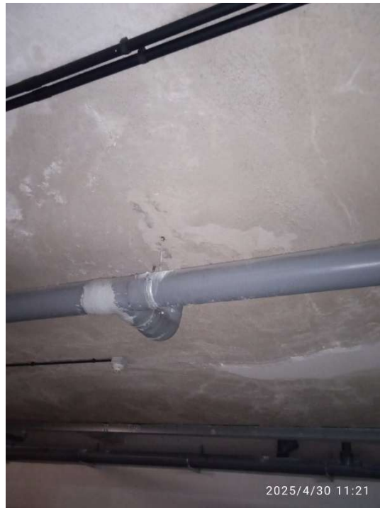
Después de la prueba de agua
