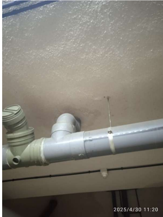
Después de la prueba de agua
