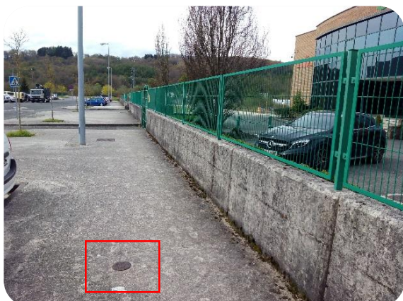
Punto 144: BR tipo "lanza" en red general PI de FNØ125mm
