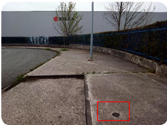
Punto 129B: BR tipo "lanza" en red general PI de FNØ150mm
