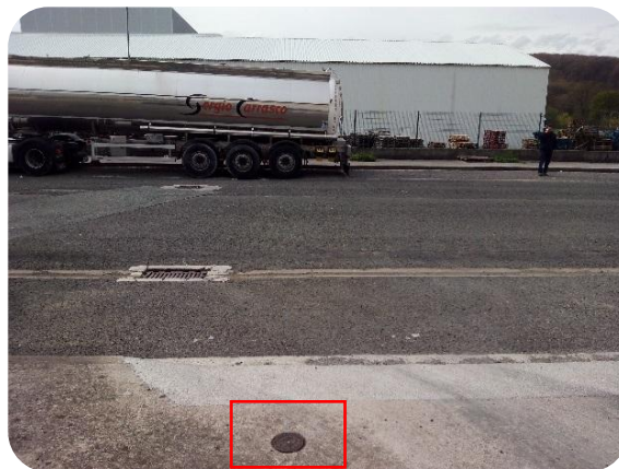
Punto 141: BR tipo "lanza" en red general PI de FNØ150mm
