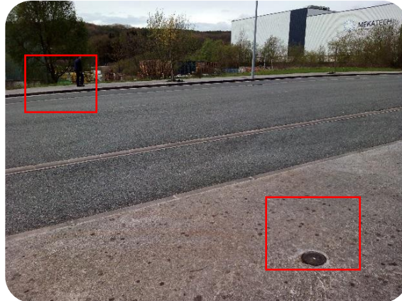
Punto 152: BR (2ud) tipo "lanza" en red general FNØ150mm
