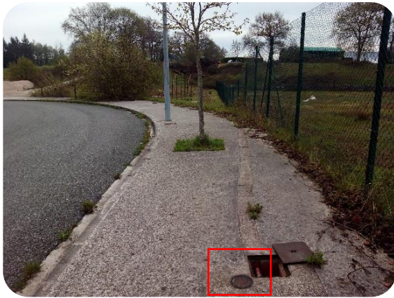
Punto 121: BR y registro 40x40 derivación acometida granja.
