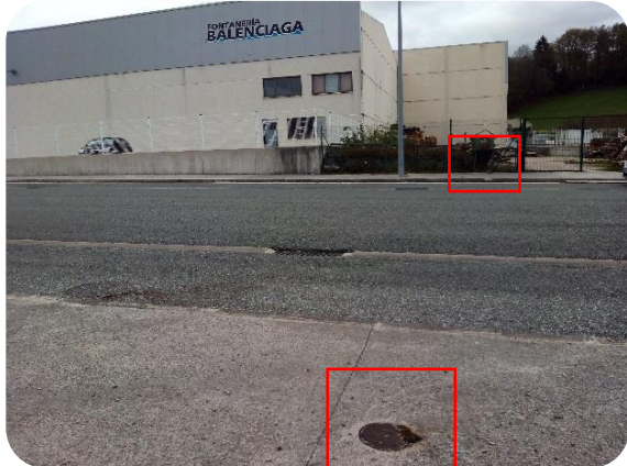
Punto 151: BR (2ud) tipo "lanza" en red general FNØ150mm
