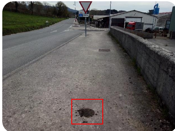
Punto 156: BR tipo "lanza" en red general PI de FNØ150mm
