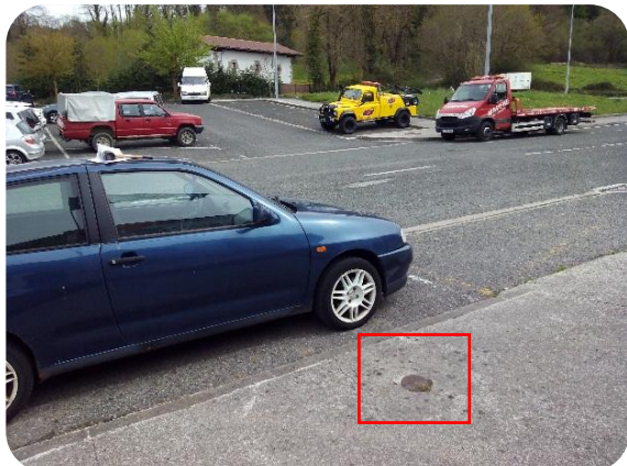
Punto 155: BR tipo "lanza" en red general PI de FNØ150mm
