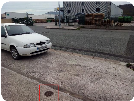
Punto 134: BR (2ud) tipo "lanza" en red general PI de FNØ300
