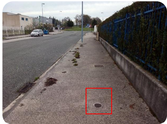
Punto 126: BR tipo "lanza" en red general PI de FNØ300mm
