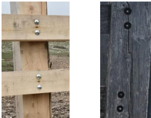
Imagen nº4: Detalle tornillería, imagen 1 parte interna en contacto con ganado, bu buena colocación de los tornillos, imagen derecha realización avellanado en la zona posterior para colocación tuercas
