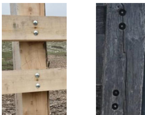
Imagen nº9: Detalle tornillería, imagen 1 parte interna en contacto con ganado, bu buena colocación de los tornillos, imagen derecha realización avellanado en la zona posterior para colocación tuercas
